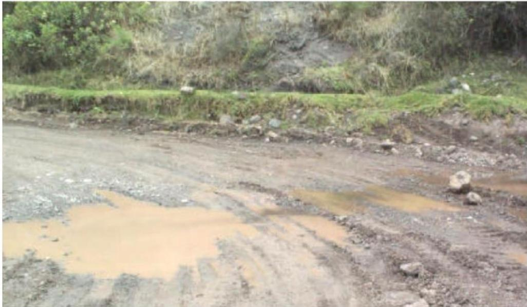
**Figura N°22:** Lodazal, transitabilidad baja o intransitabilidad en épocas de lluvias.
