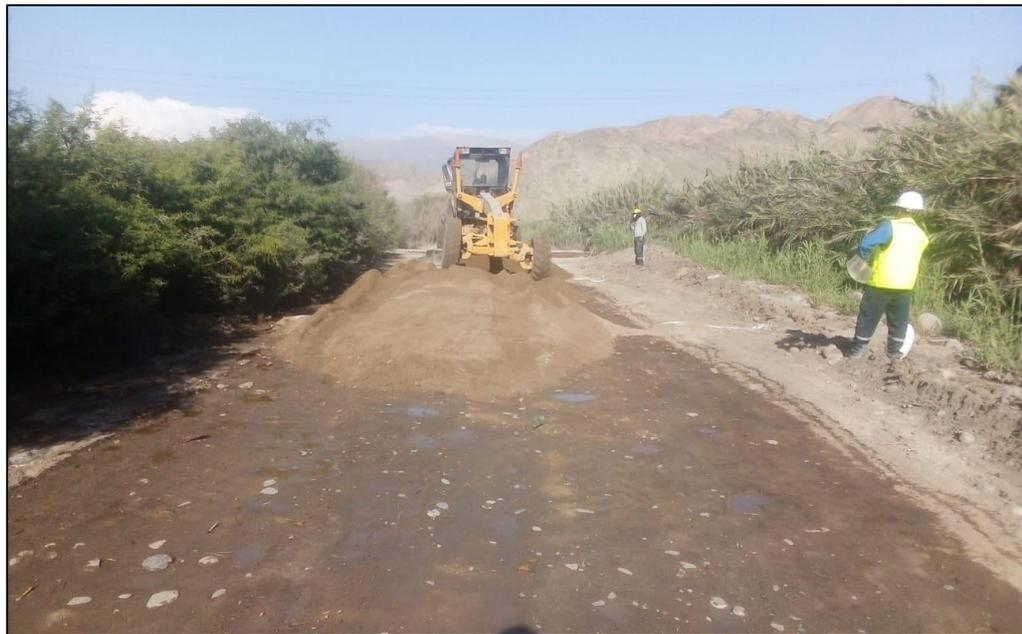
**Figura N°49:** Distribución de material para la base granular de la carretera, en el Cp. Herbay Alto – San Vicente – Cañete
