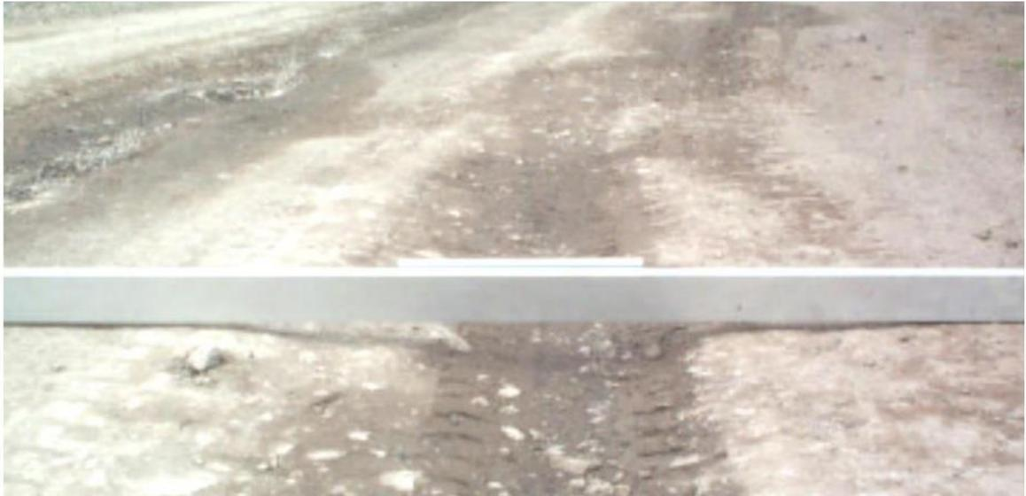
**Figura N°16:** Erosión, si es de gravedad 2, tiene una profundidad entre de 5 cm y 10 cm
