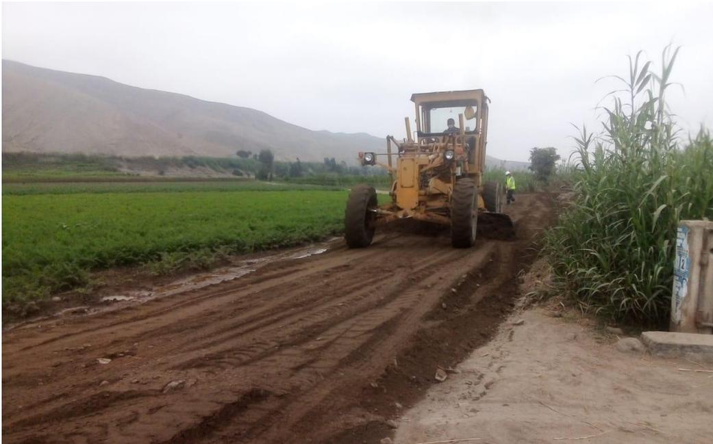
**Figura N° 93:** Conformación del material para la base granular
