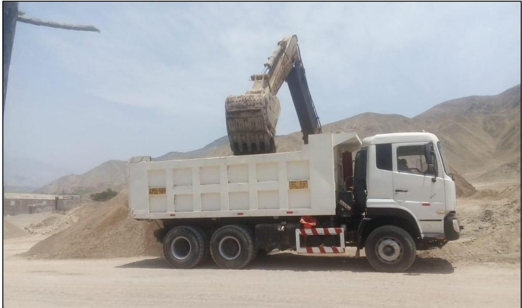
**Figura N°47:** Transporte del material granular zarandeado en el Cp. Herbay Alto – San Vicente – Cañete
