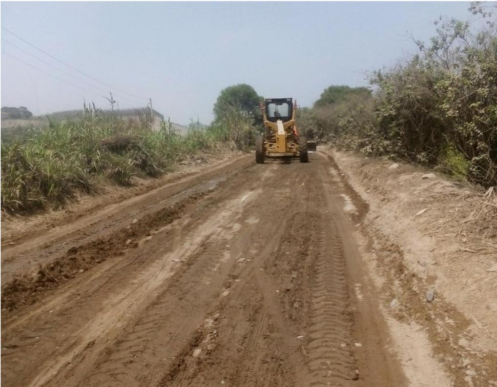
**Figura N° 88:** Preparación de la superficie existente del camino
