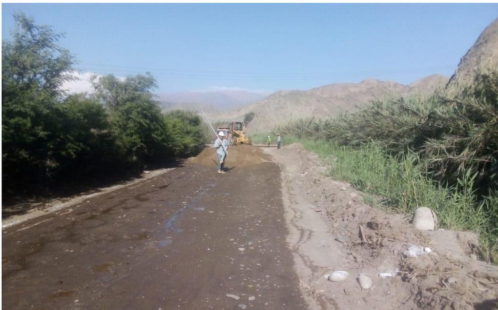
**Figura N° 91:** Extendido del material para la base granular
