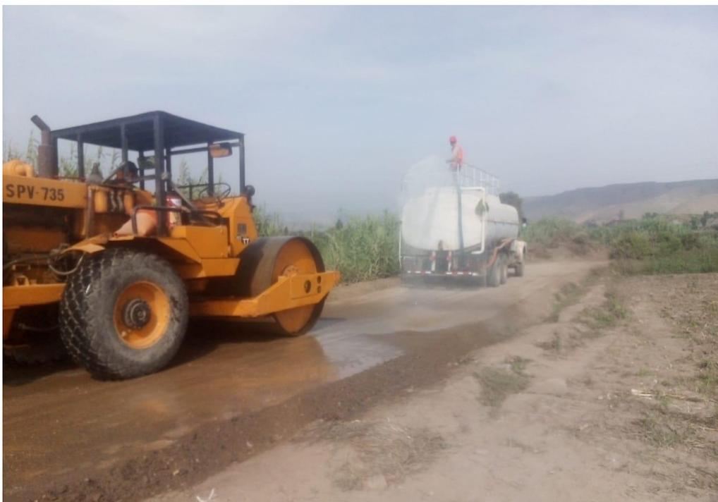
**Figura N° 95:** Regado del material para la base granular
