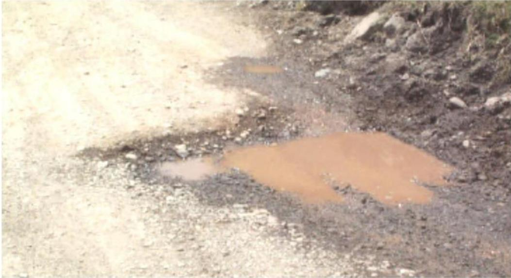
**Figura N°18:** Baches (huecos), si es de gravedad 1 puede repararse con mantenimiento rutinario
