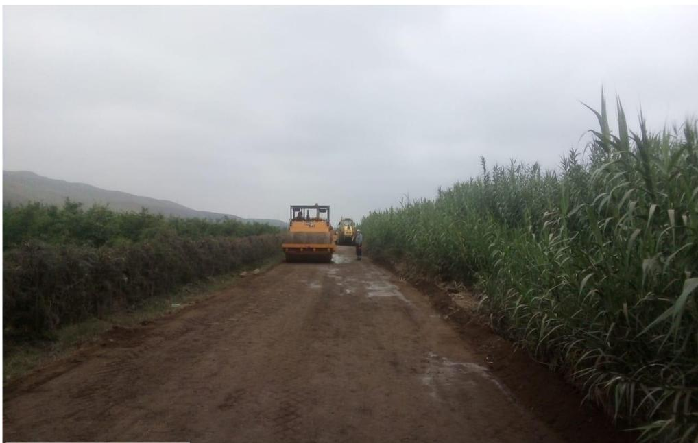
**Figura N° 94:** Compactación del material para la base granular
