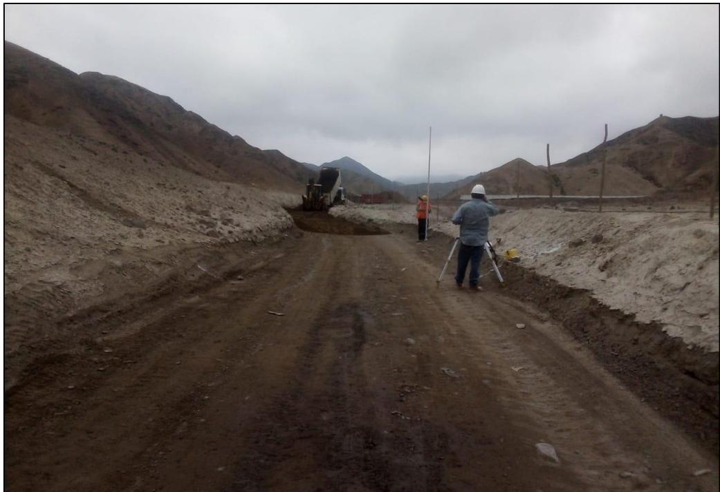
**Figura N°45:** Trazo y replanteo del camino no pavimentado del Cp. Herbay Alto – San Vicente – Cañete
