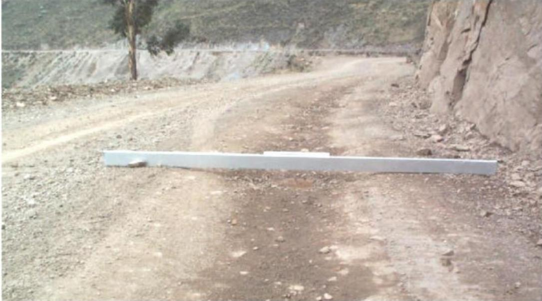
**Figura N°14:** Deformación, si es de gravedad 3, produce huellas – hundimientos mayor e igual a 10 cm
