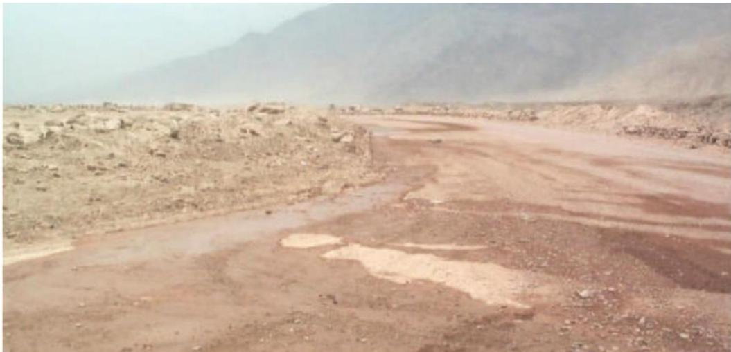
**Figura N°19:** Baches (huecos), si es de gravedad 2 necesita una capa de material adicional
