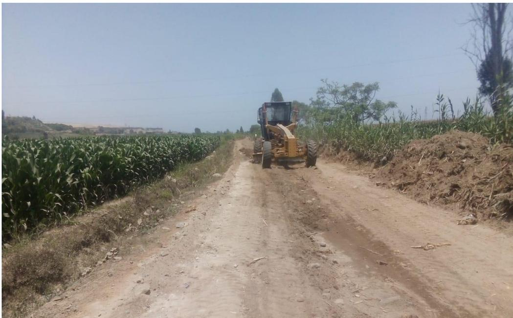
**Figura N° 89:** Preparación de la superficie existente
