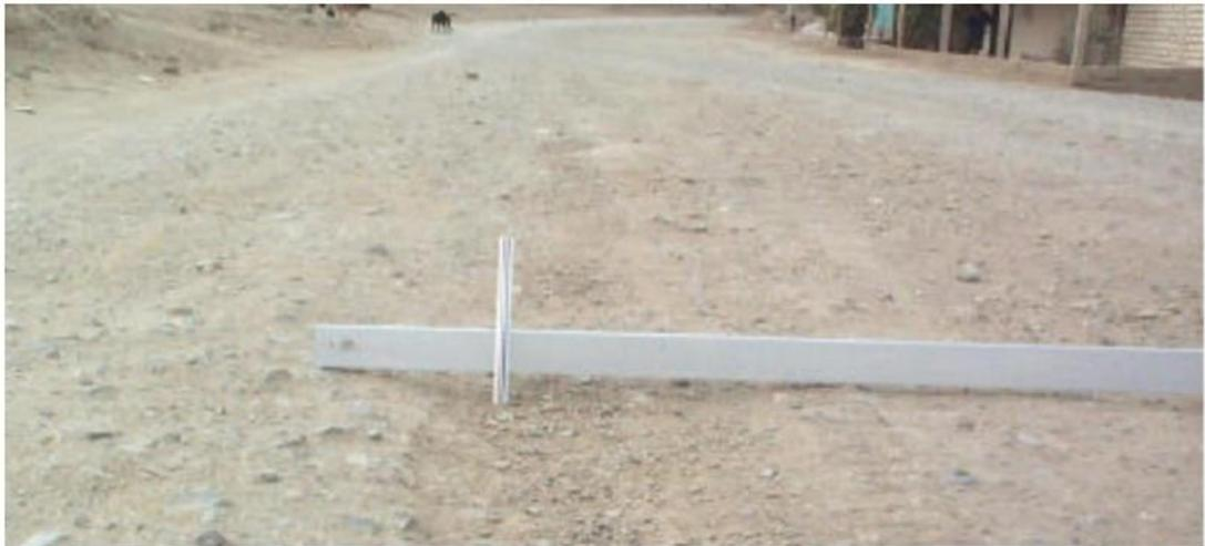
**Figura N°12:** Deformación, si es de gravedad 1, produce huellas – hundimientos sensibles al usuario, pero menor a 5 cm
