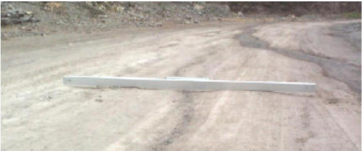
**Figura N°15:** Erosión, si es de gravedad 1, sensible al usuario, pero menor a 5 cm
