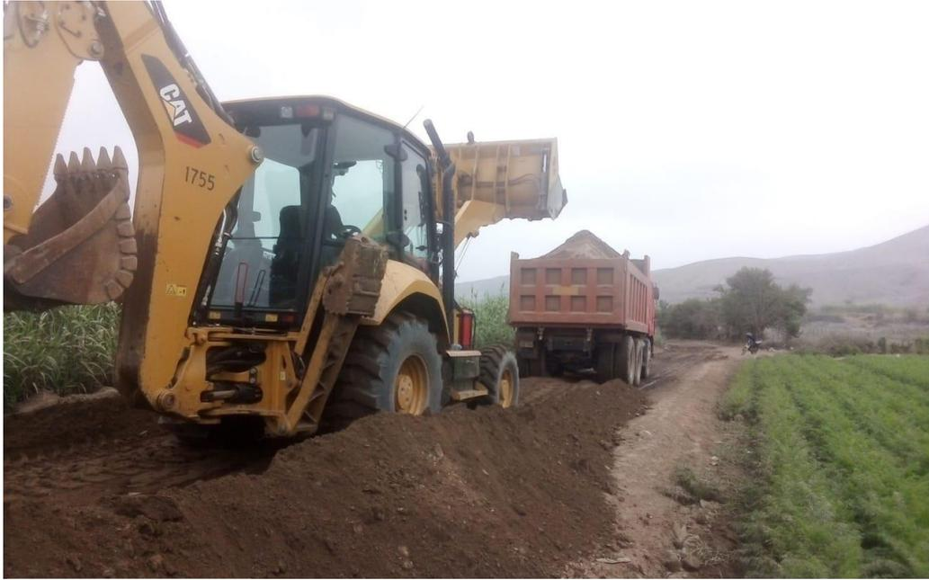
**Figura N° 92:** Colocación de material para la base granular
