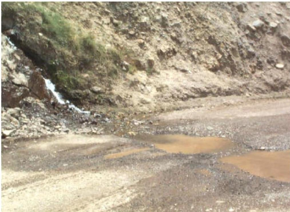
**Figura N°23:** Cruce de agua, transitabilidad baja o intransitabilidad en épocas de lluvias.
