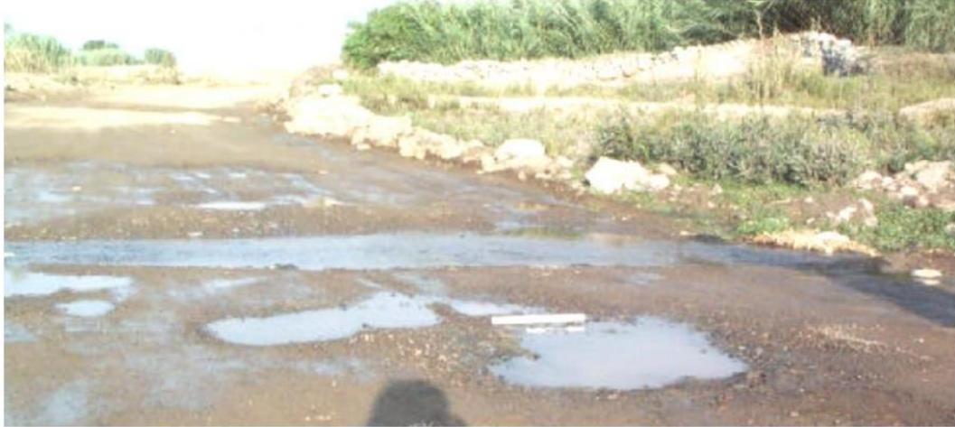
**Figura N°20:** Baches (huecos), si es de gravedad 3, necesita reconstrucción
