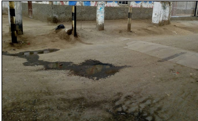
Figura 33: Jirón Sucre - Presencia de baches
