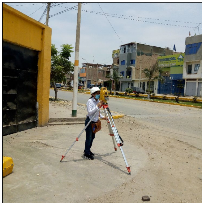
Levantamiento topográfico en la primera cuadra de la Avenida La Mar
