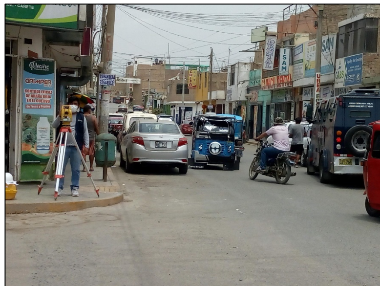
Levantamiento topográfico en el cruce de Jirón Sucre con Av. Ramos
