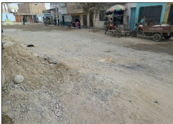
Figura 9: Tramos sin pavimentar
