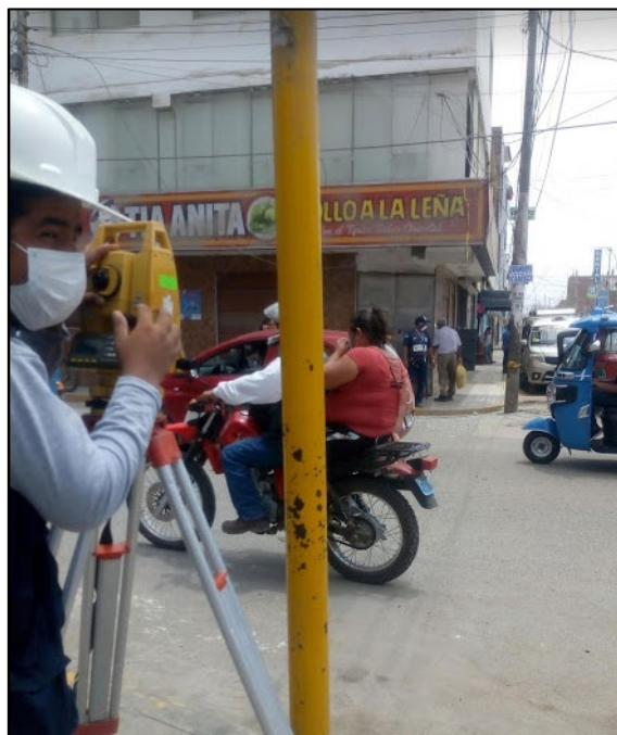
Levantamiento topográfico en el cruce de 2 de mayo con Av. Ramos
