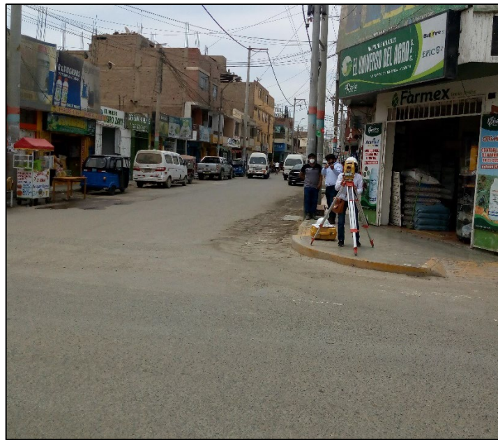
Levantamiento topográfico en el cruce de Jr. Jorge Chávez con Av. La Mar
