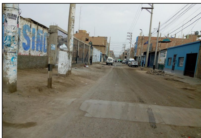
Figura 32: Jirón Sucre - Falta de acera peatonal
