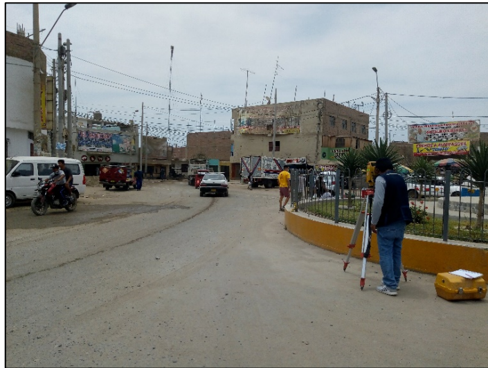
Levantamiento topográfico en la última cuadra de la Avenida La Mar
