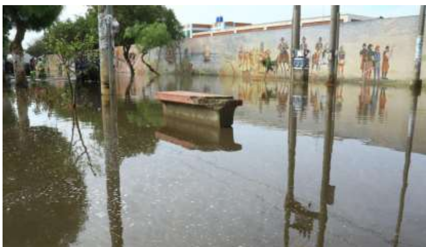
Figura 3. Zona inundada de la avenida Jesús de Nazareth - Trujillo
