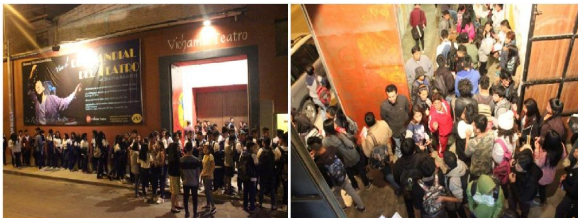
Figura 23. Falta de un espacioso foyer.
