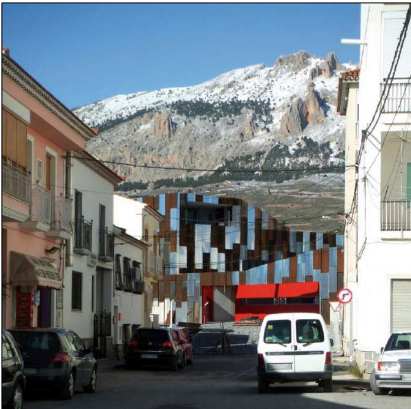
Figura 74. Integración del entorno con el centro de salud. Recuperado de https://www.archdaily.co/co/723720/centro-de-salud-en-velez-rubio-los-del-desierto
