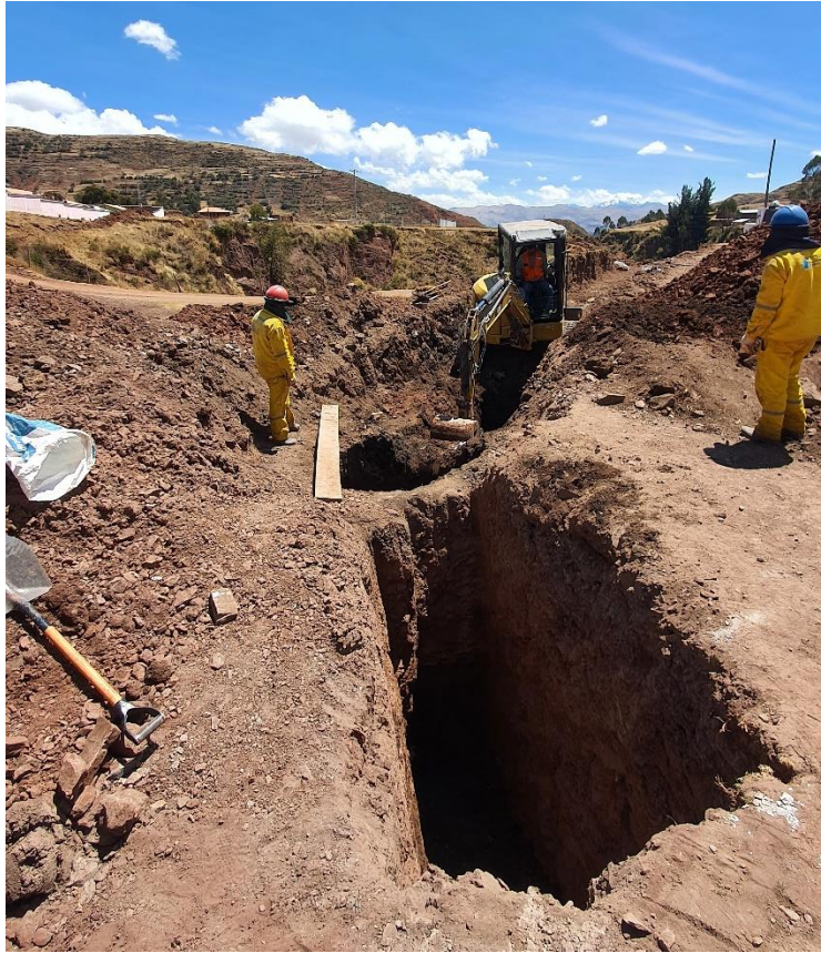
Figura 9 Trabajo de excavaciones Fuente: Elaboración Propia
