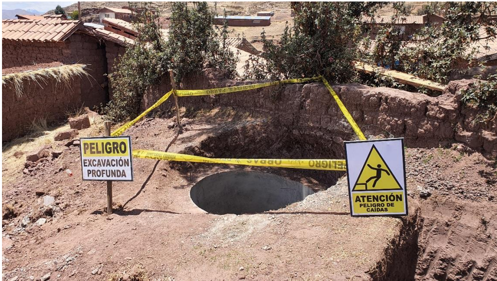
Figura 29 Vaciado de buzones Fuente: Elaboración Propia
