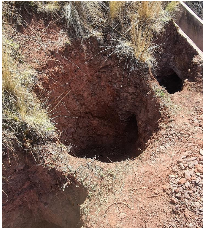
Figura 10 Excavaciones de buzones Fuente: Elaboración Propia
