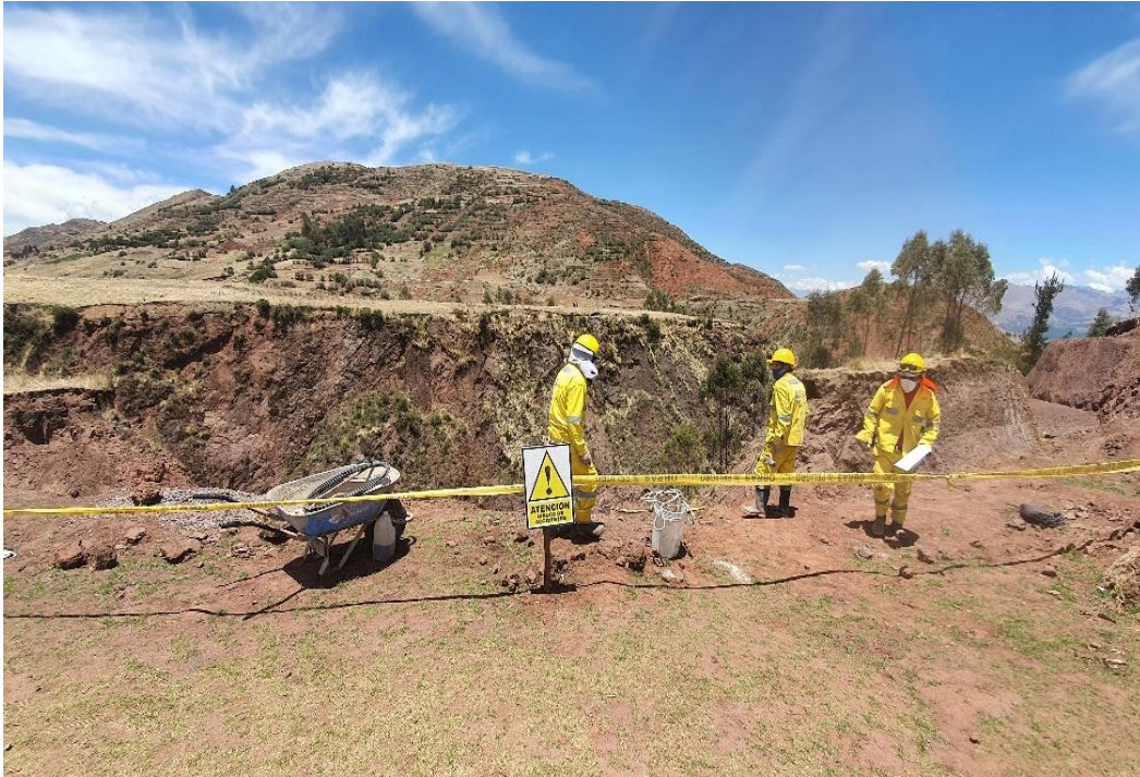
Figura 28 Frente de trabajo Fuente: Elaboración Propia
