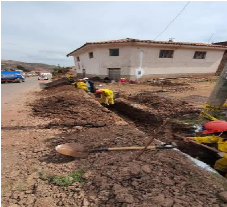
Figura 5 Trabajo en excavaciones Fuente: Elaboración Propia
