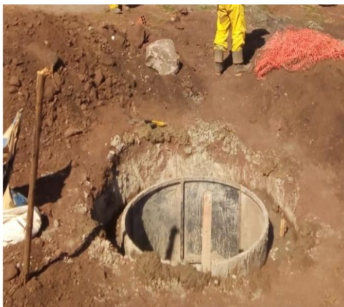
Figura 11 Vaciado de buzones Fuente: Elaboración Propia
