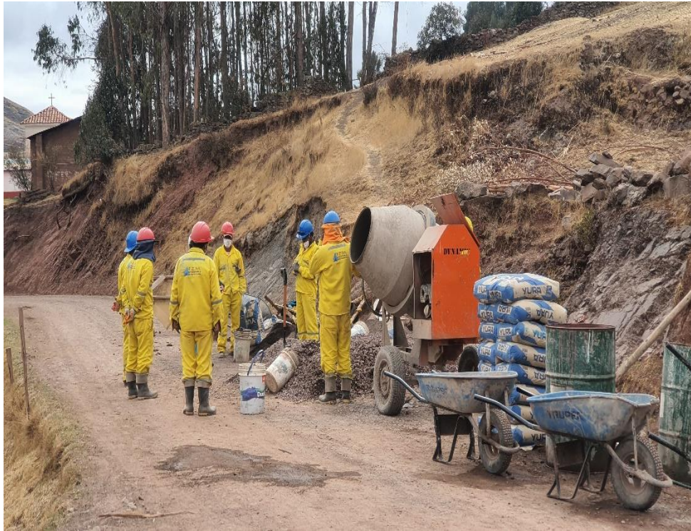
Figura 7 Trabajos de vaciado de buzones Fuente: Elaboración Propia
