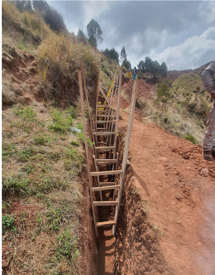
Figura 30 Excavaciones y Entubado de desagüe Fuente: Elaboración Propia
