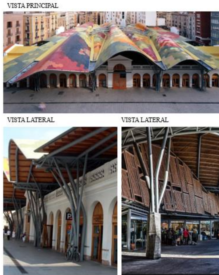
Figura 13: Vistas externas del Mercado Santa Catarina
