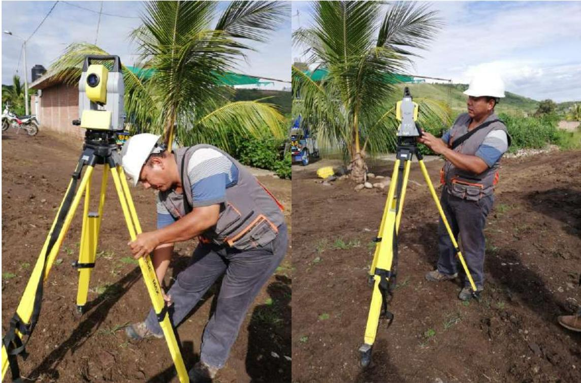
Fotografía 1 y 2: Realizando la Est-1 ingresando datos obtenidos con GPS para inicio de levantamiento.
