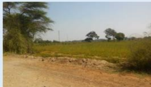
Vía sin asfalto
