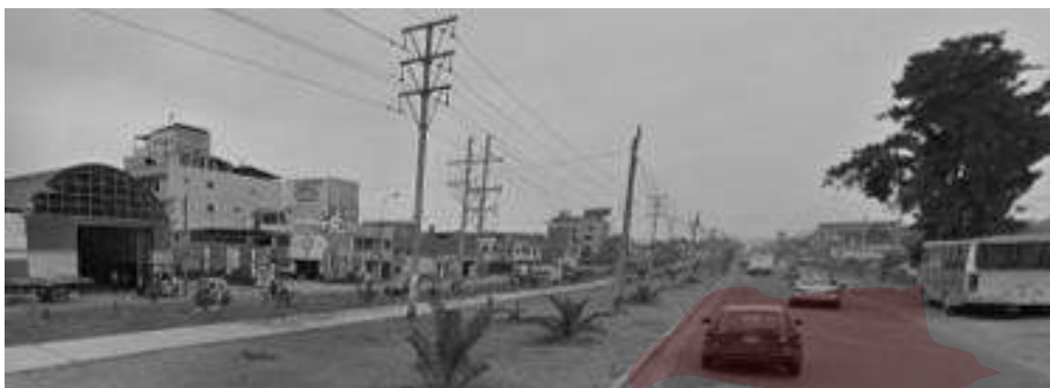
Figura70. Falta de señalización horizontal en la Av. Pedro Miotta, San Juan de Miraflores. Fuente: Archivos Fotográficos del entorno del área de estudio. Imágenes de Google (2019)
