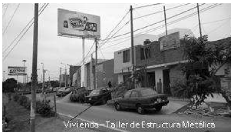
Figura77. Foto 03 - Vivienda Taller Aux. Panamericana Sur, San Juan de Miraflores. Fuente: Archivos Fotográficos del entorno del área de estudio. Fotografía Propia
