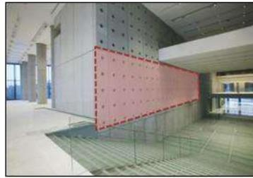
Paneles de hormigón perforado cubren compresores externos de aislamiento acústico.
