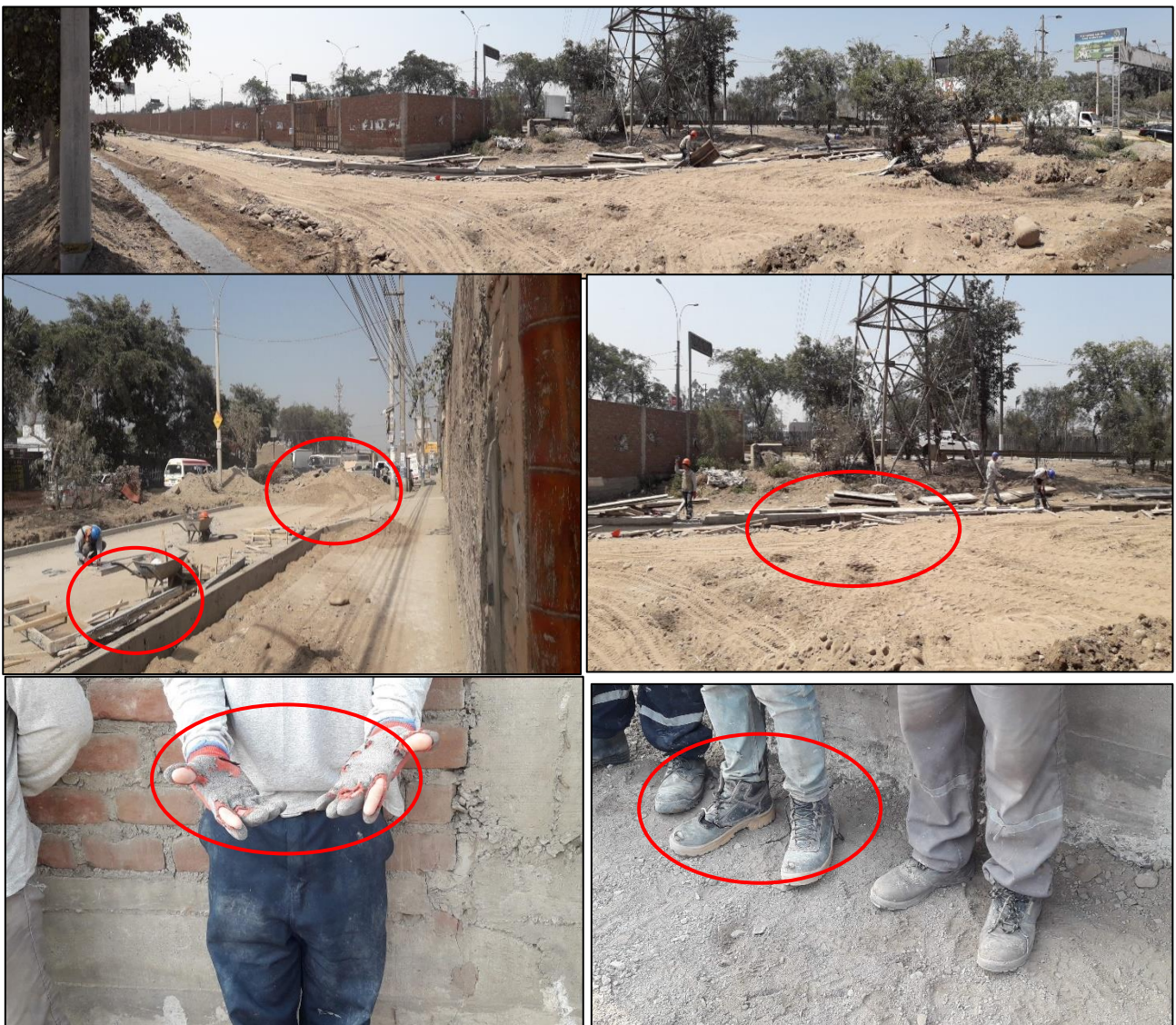
Figura 6: Evidencias de la obra antes de la aplicación
