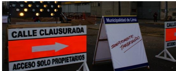
Figura 9: Señalética de acceso en obra
