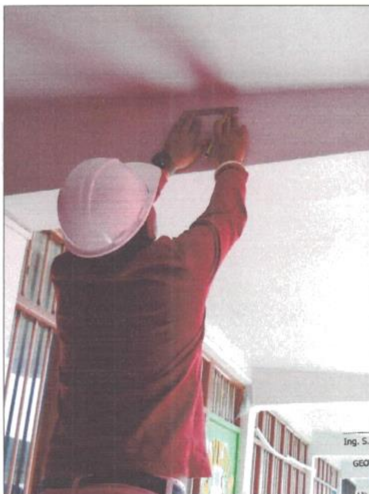
FOTO 03: TRAZADO DE PUNTOS PARA EL ENSAYO DE REBÓTE EN EN VIGA DEL AJILA 3RO "A" - ANGULO (0°).
