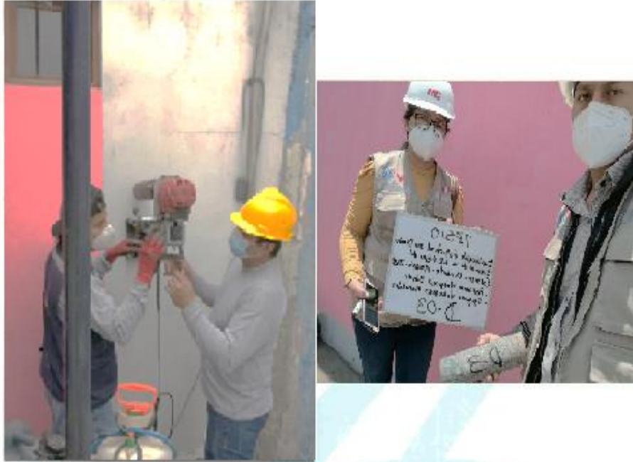
Figura N°03: Colocación de equipo y extracción de núcleo de concreto
