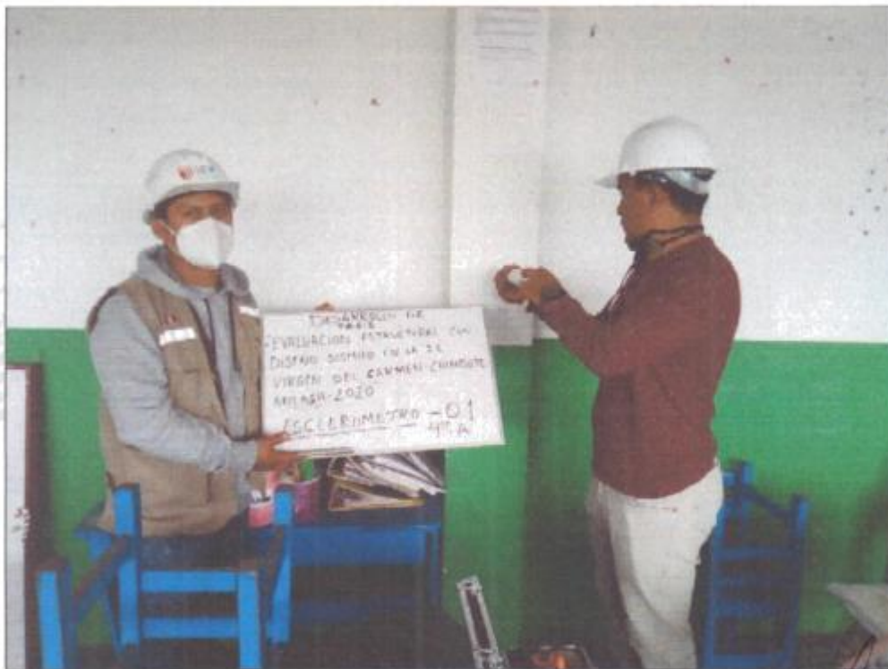
FOTO 02: REALIZANDO EL ENSAYO DE REBOTE ESCLERÓMETRO EN LA COLUMNA DEL 4TO "A" - ANGULO (0°)
