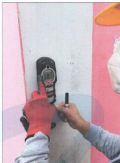
Figura N°02: Marcado de área de extracción con detector de metales en columna.
