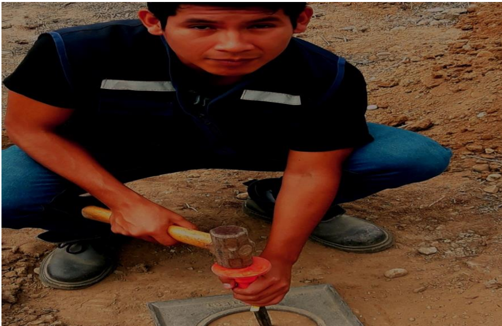
Fotografía 6. Realizando ensayo de Cono de Arena
