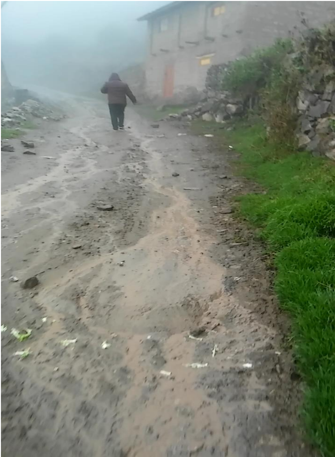
Fotografía 4: Calle S/N Anexo de Picamaran km. 0+500
