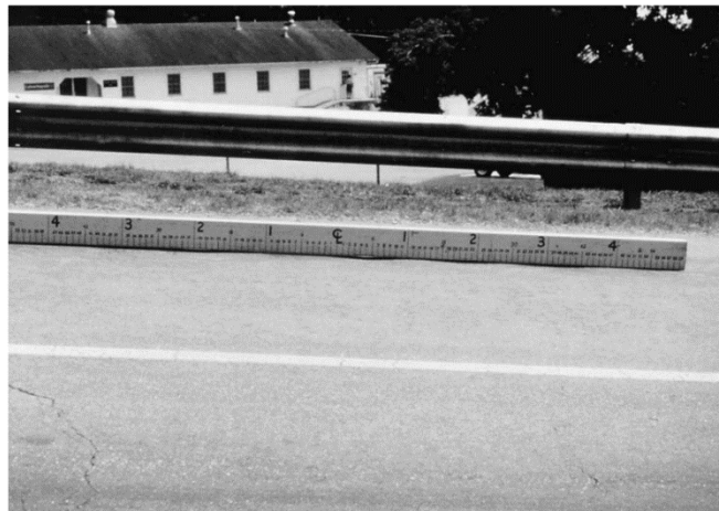
Figura 22 : Corrugación de baja severidad
