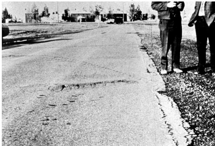
Figura 21 : Abultamientos (Bumps) Y Hundimientos (Sags) de media severidad
