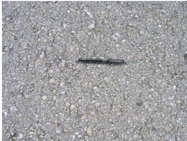
Figura 64 : Meteorización (Desgaste superficial) - Asfalto de mezcla denso de media
