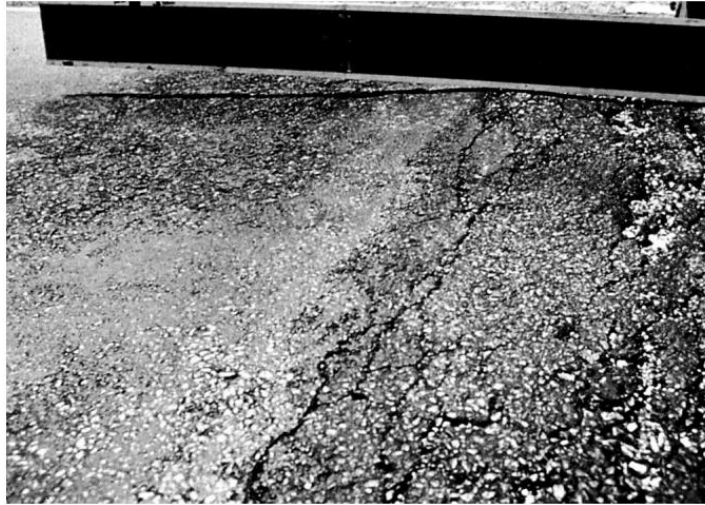
Figura 22 : Corrugación de baja severidad
