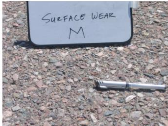
Figura 64 : Meteorización (Desgaste superficial) - Asfalto de mezcla denso de media
