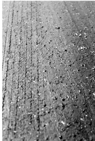
Figura 17 : Agrietamiento en bloque de baja severidad
