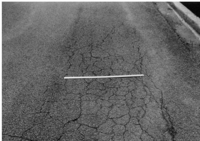
Figura 12 : Piel de cocodrilo de media severidad
