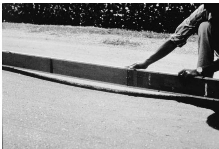
Figura 27 : Depresión de medio severidad
