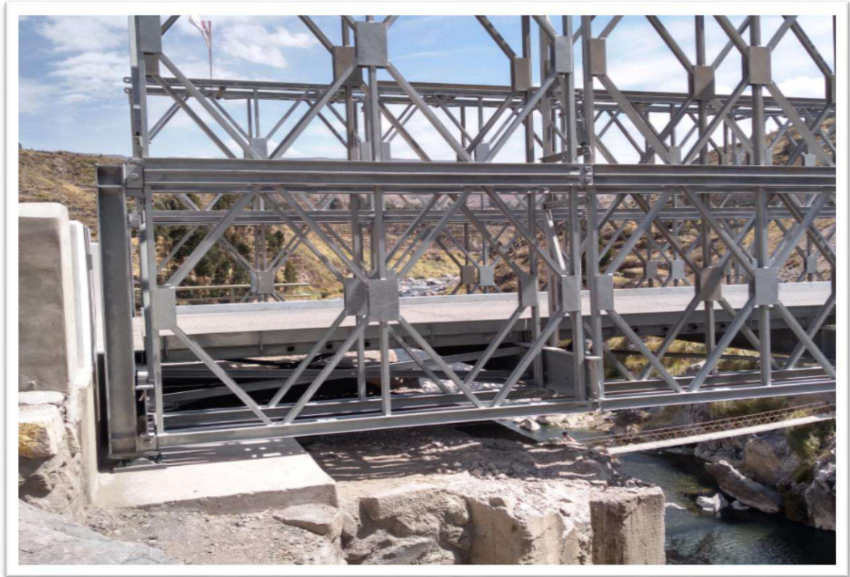
Ilustración: apoyos del puente temporal
