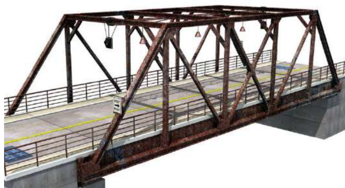
Figura 7. Puentes de acero
