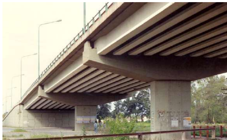
Figura 10. Puentes de postensado
