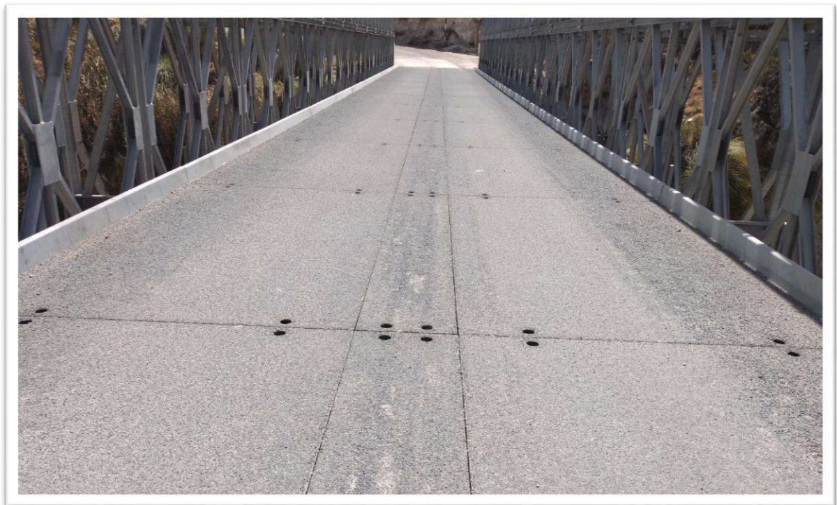
Ilustración: losa de tablero del puente temporal
