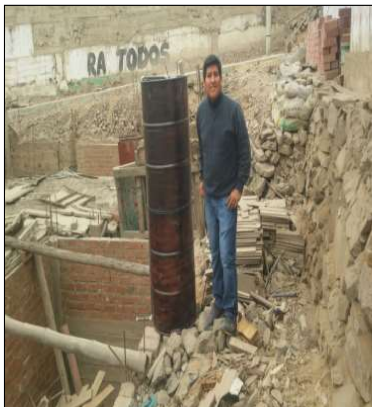
Figura 1. Construcción de filtro biológico
