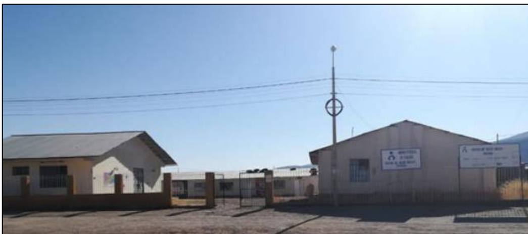
Figura 26. Centro de salud del Distrito de Puyusca del departamento de Ayacucho.
