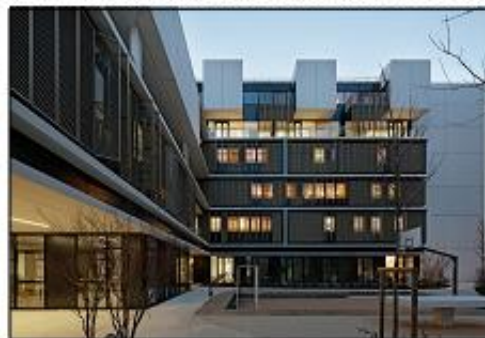
Elevación Norte: La cubierta en madera, y las transformaciones volumétricas que son una adición a los volúmenes.
