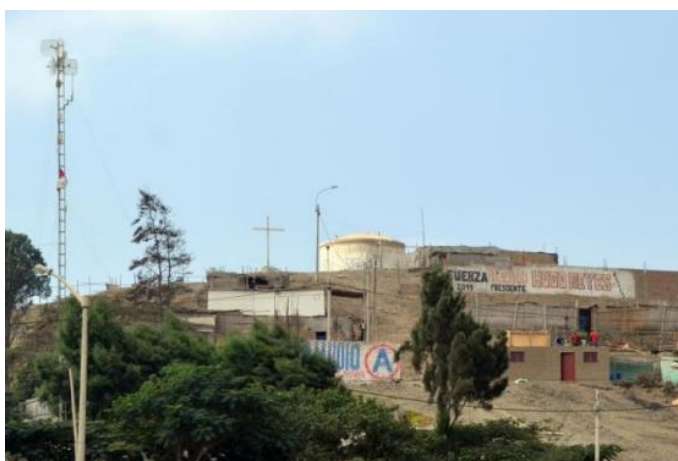
Figura N°16: Foto del Reservorio Elevado
