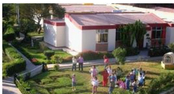
VISTA EXTERIOR DE UNA DE LAS VIVIENDAS DE LA ALDEA INFANTIL SOS-AREQUIPA
