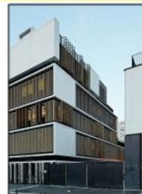
Elevación Sur: En esta fachada predomina la cubierta de madera, se observa su forma escalonada donde se encuentran las terrazas.
