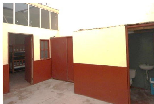
Figura N°02: Realidad problemática del Albergue de la Beneficencia. Fuente: Sociedad de Beneficencia de Huacho
