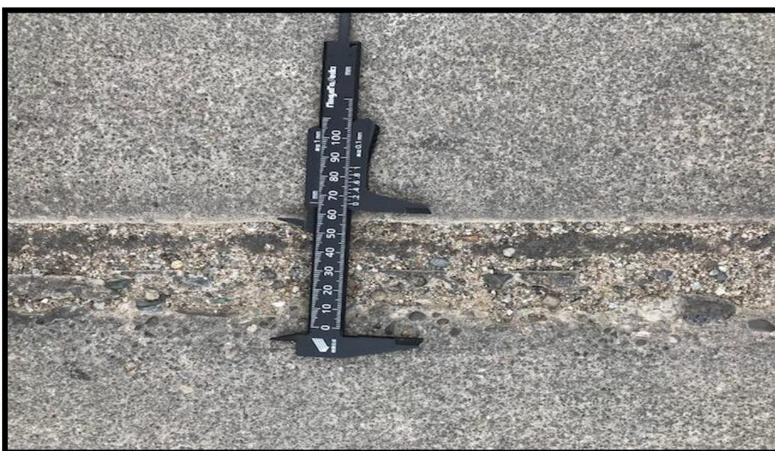
**Figura 20:** midiendo la junta con vernier
