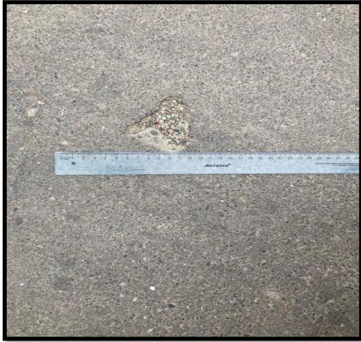
**Figura 21:** midiendo los vacíos en el pavimento
