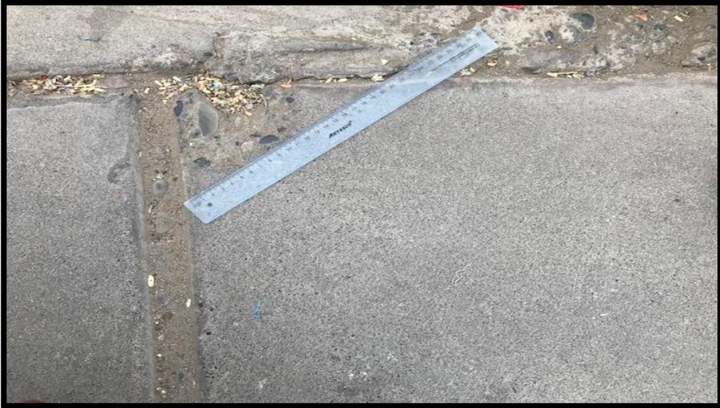
**Figura 17:** *midiendo la intersección de las juntas.*
