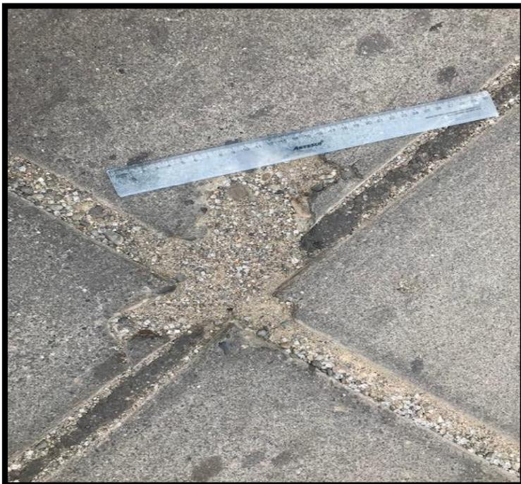
**Figura 22:** Intersección de las juntas
