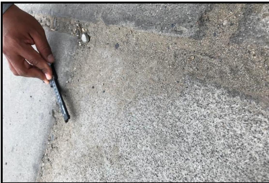
**Figura 19:** midiendo la junta en diagonal.
