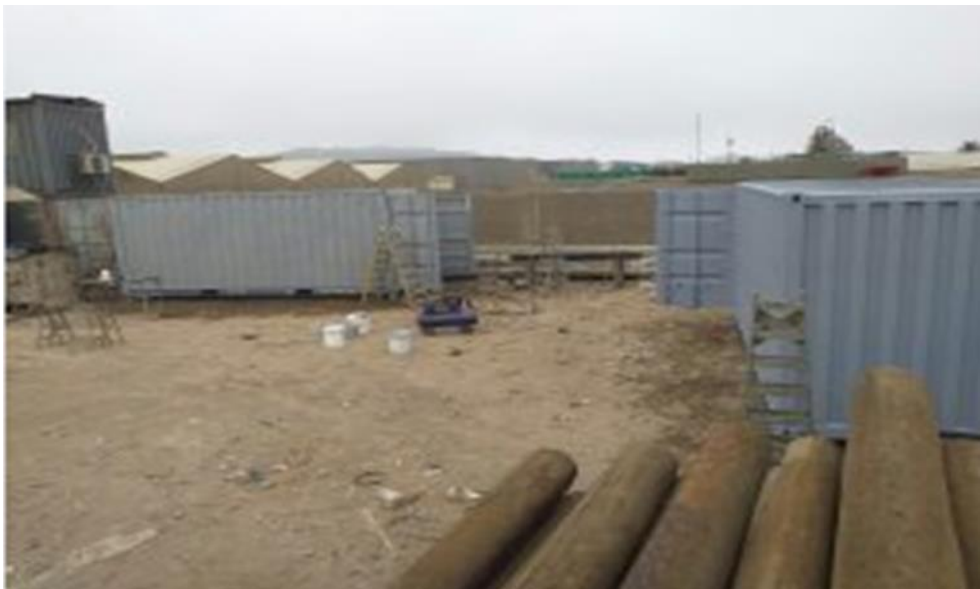
Figura 8: Área de producción de módulos prefabricados.
