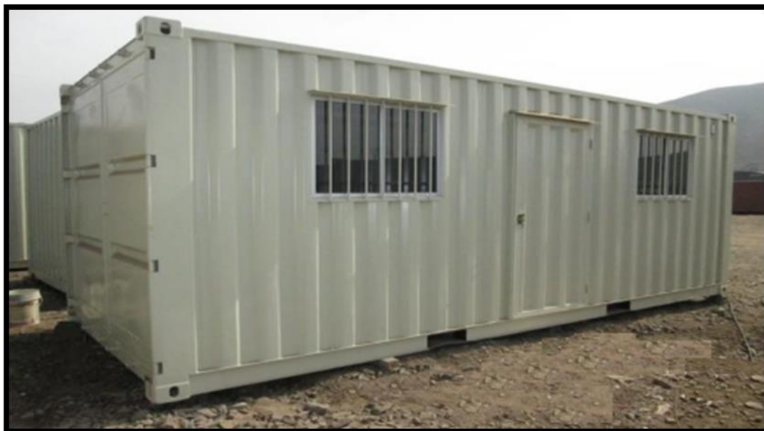
Figura 13: Oficina ST en base a contenedor marítimo.
