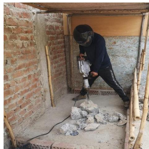
Imagen N° 70: Triturado de los bloques de Concreto para la Obtención del del agregado Reciclado
