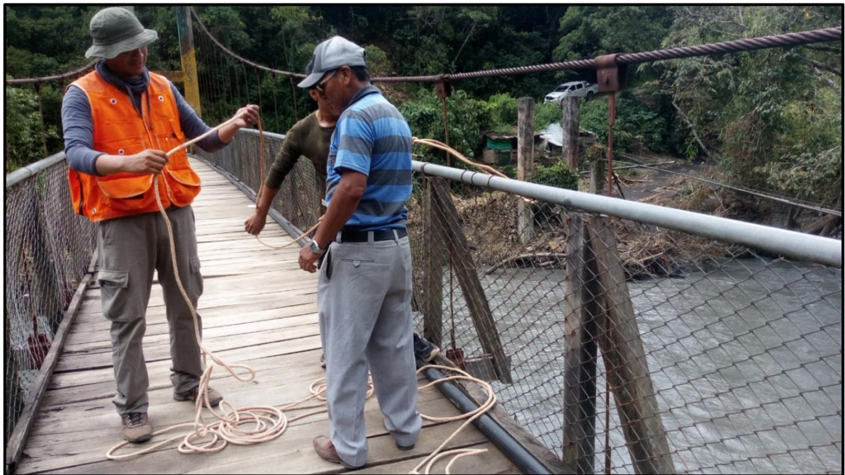
Fotografía 02. Se está realizando la medición de la batimetría en el puente existente, utilizando un método artesanal con cuerda y piedra.
