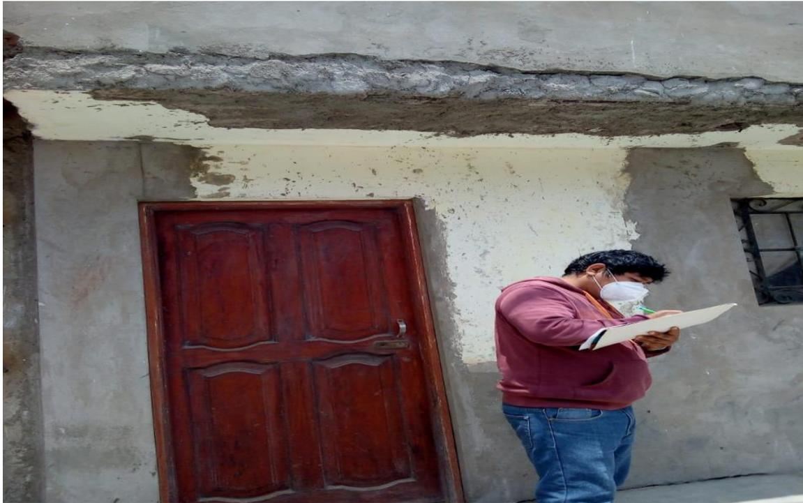
*Figura 59 Deterioro en losas de vivienda*
