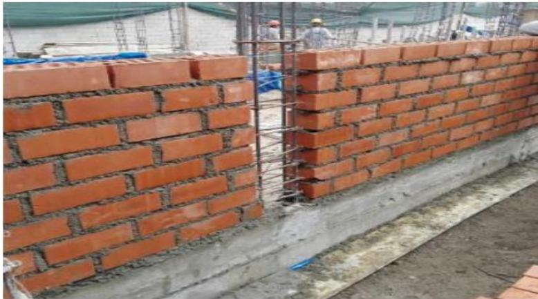
Figura 1. Albañilería confinada.
