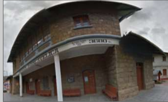
Figura22: Imagen de la Estación Central (Tren Macho)
