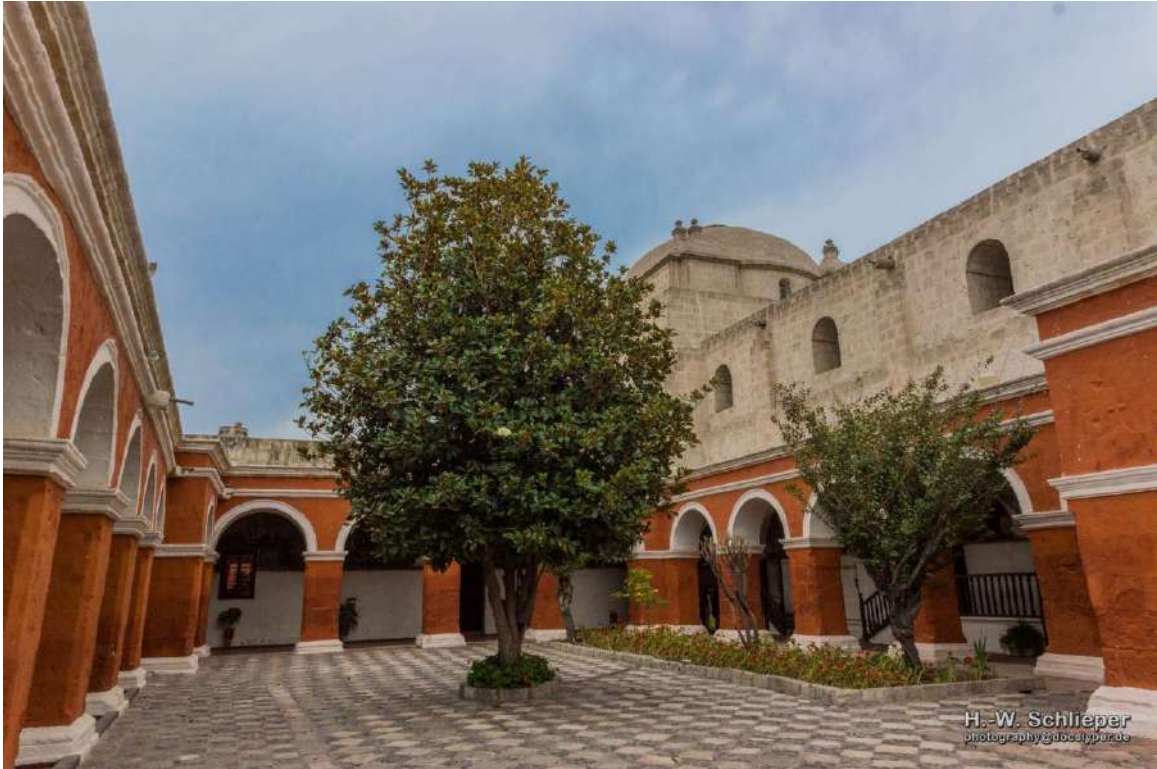
Foto N° 8. Patio del monasterio Santa Catalina. Tomado de H.W. Schlieper.
