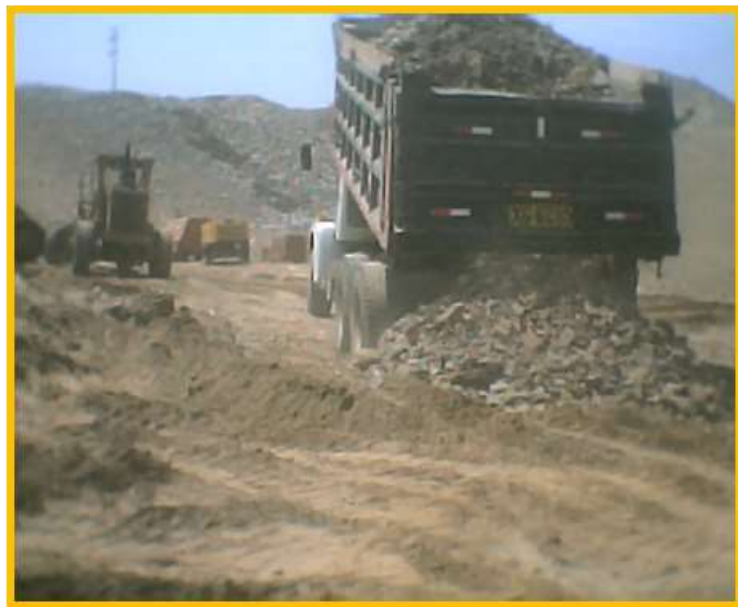
Figura 17. Material para mejorar la subbase. Fuente: Propia.
