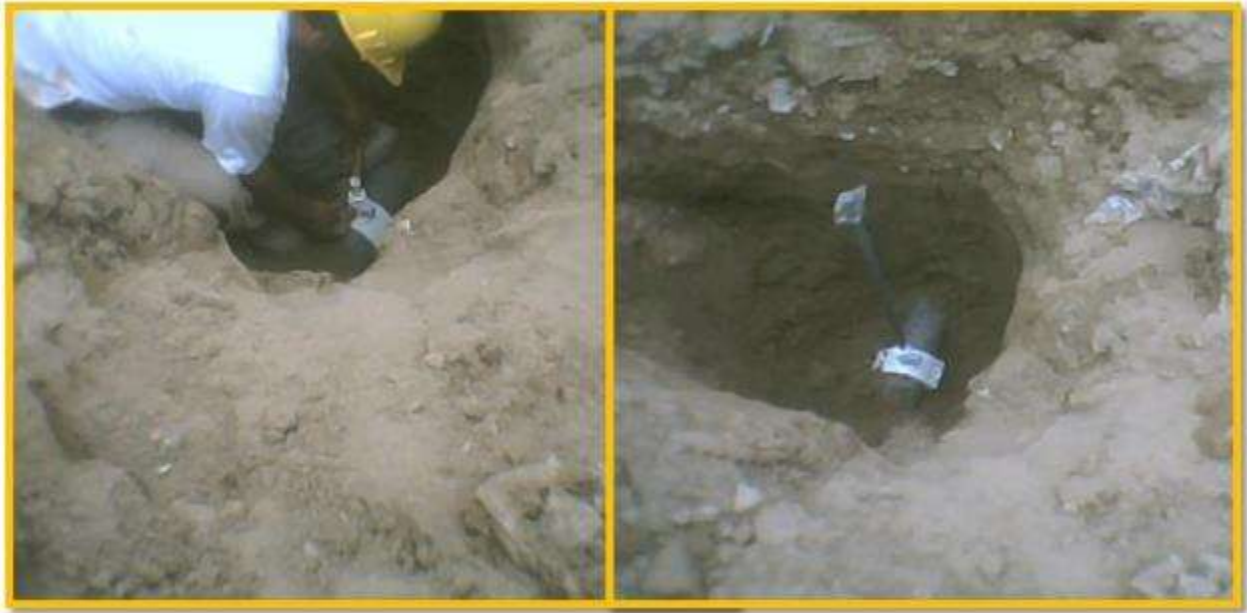
Figura 27: Colocación de abrazaderas y válvulas.
