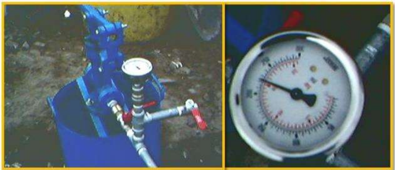
Figura 26: Balde y manómetro para prueba hidráulica.
