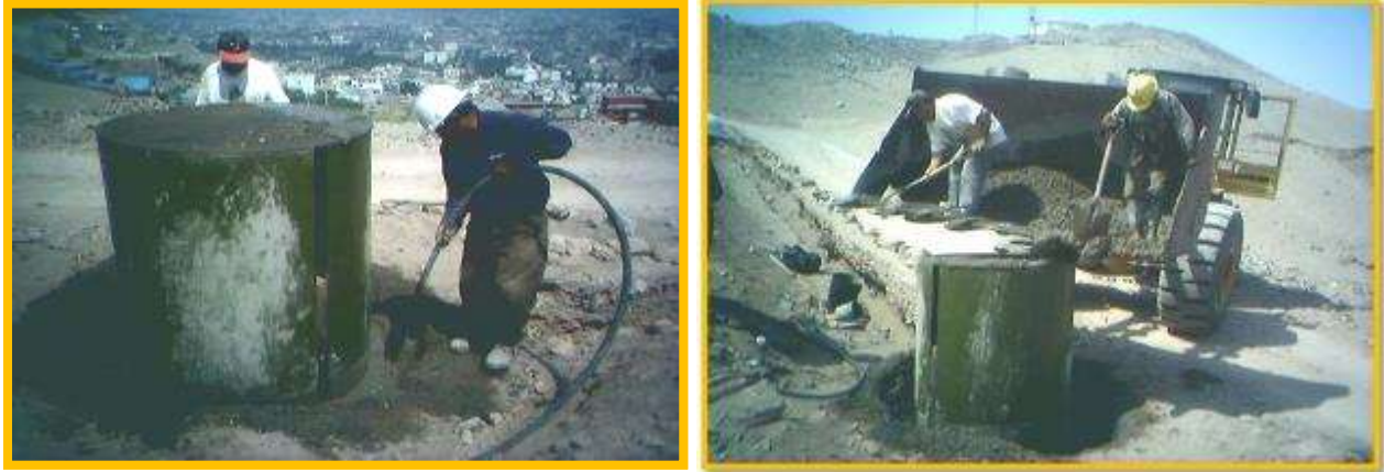
Figura 41: Encofrado y vaciado para buzón.
