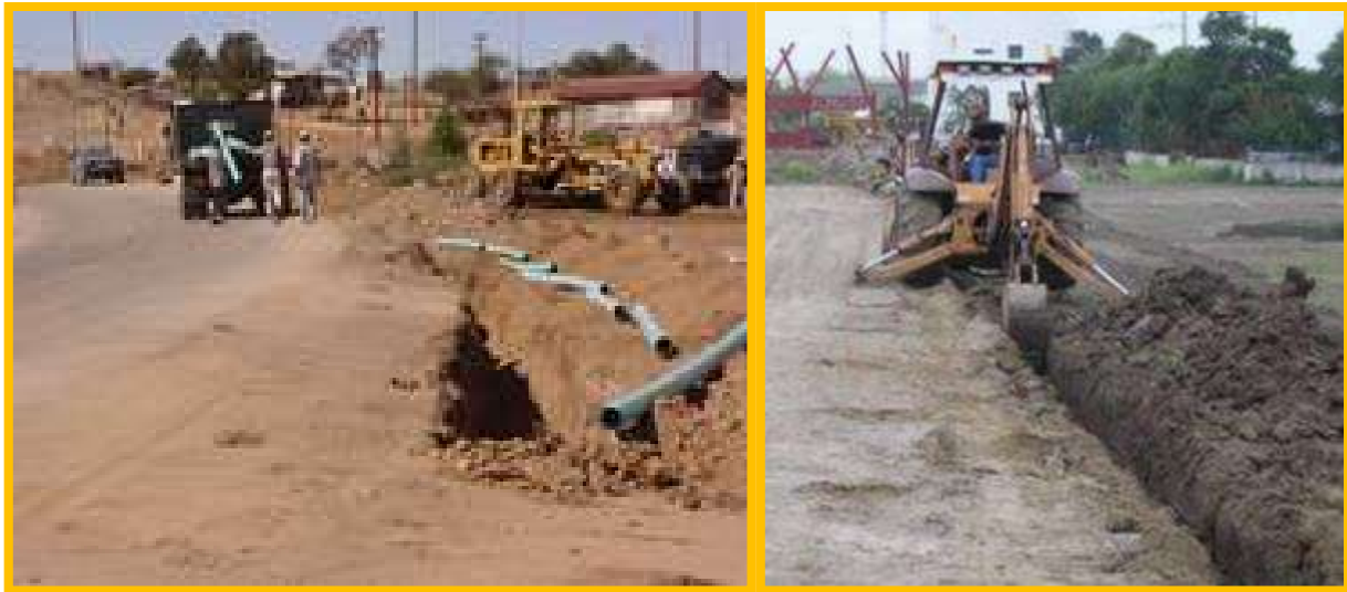
Figura 25: Excavación y tendido – red de agua.
