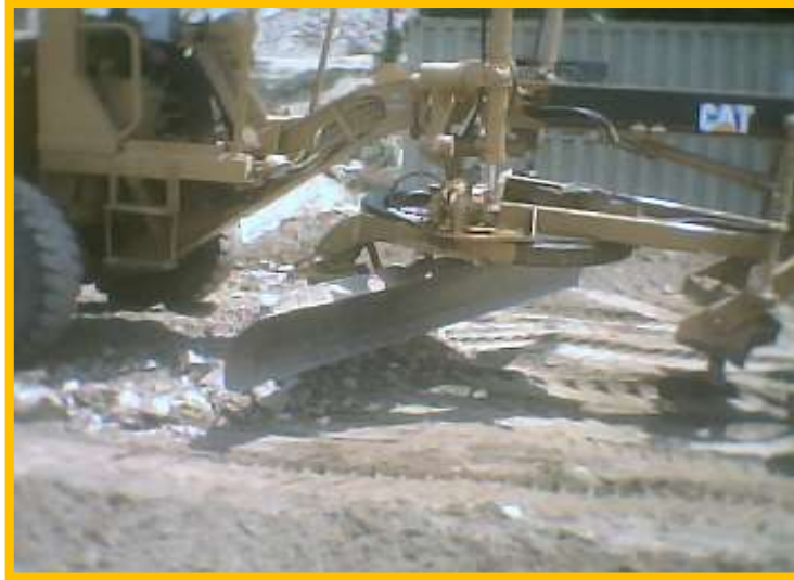
Figura 18. Extendiendo el material para mejorar la subbase.
