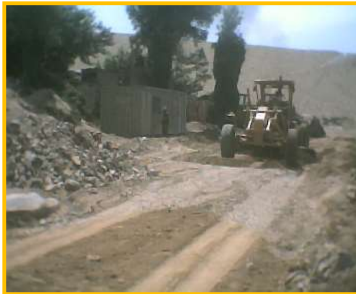
Figura 19. Zona mejorada con material de préstamo.
