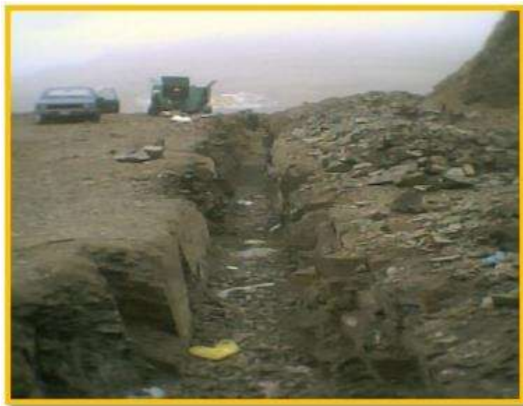
Figura 40: Plantillas en zanja de desagüe. Fuente: Propia.
