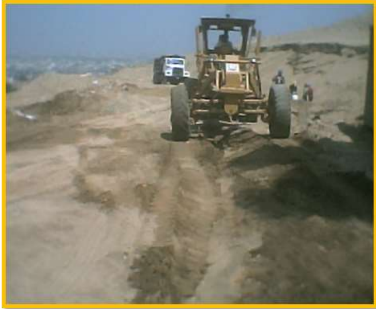
Figura 16. Corte de la subbase Fuente: Propia.
