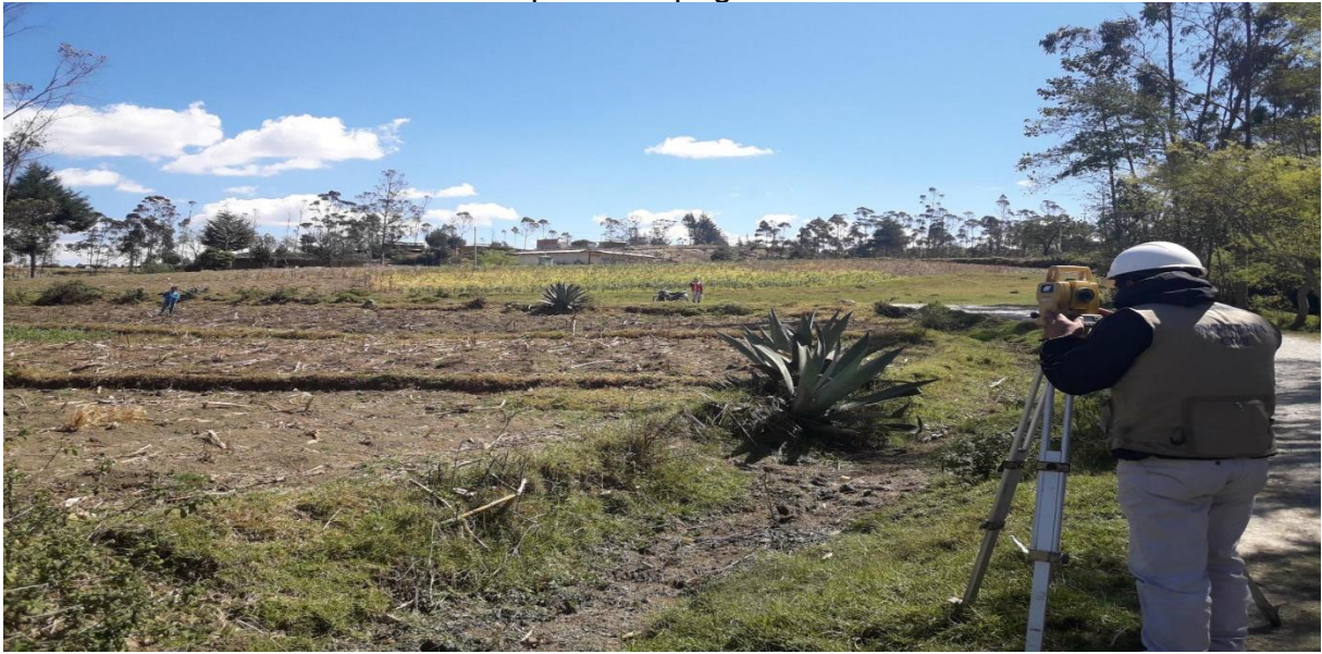
Foto 3: Recolección de puntos topográficos
