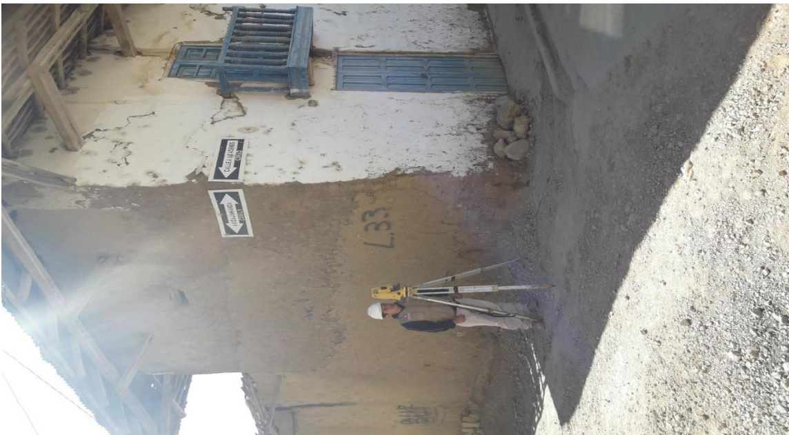
Foto 6: Toma de datos del teodolito
