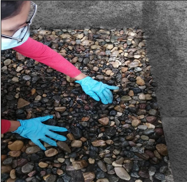
Agregado de piedra en la cámara ascendente.
