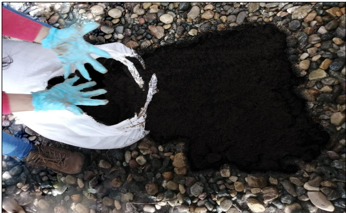
Agregado de carbón activado en la cámara ascendente.
