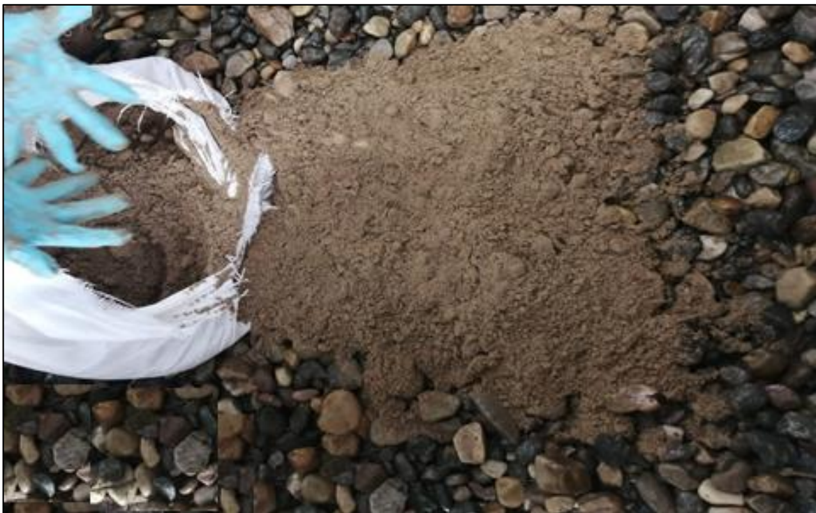
Agregado de Arena gruesa en la cámara descendente. Fuente: Elaboración propia, 2021.
