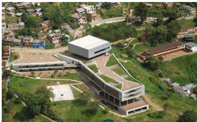
Figura 79. Integración + arquitectura + espacio público Colegio Santo Domingo Savio Medellín, Colombia 202
