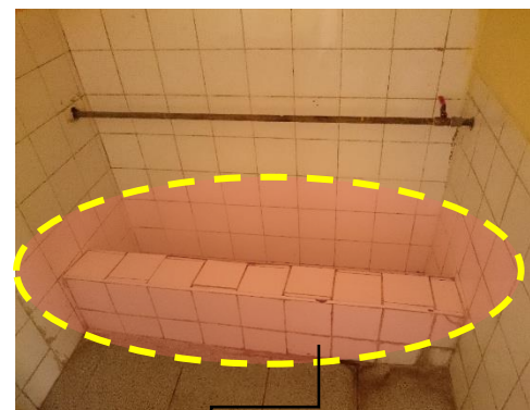
FOTOGRAFIA N° 11 FUENTE: ELABORACION PROPIA.
