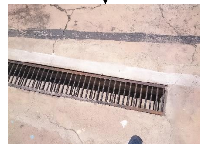
FOTOGRAFIA N°03 FUENTE: ELABORACION PROPIA.
