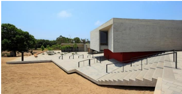
Figura N° 51. Plataforma insertado en su topografía
