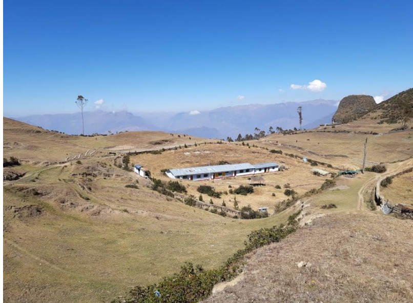
Figura 6. Reconocimiento de campo de estructuras existentes
