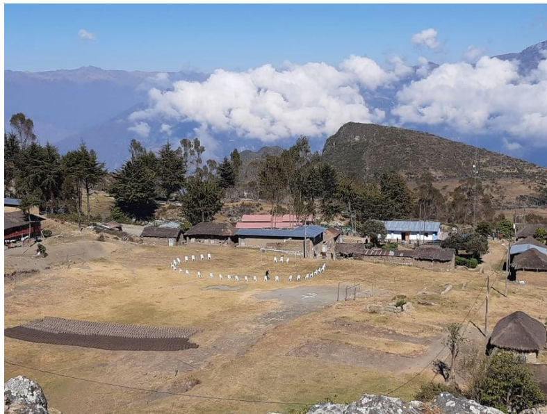
Figura 7. Reconocimiento de campo de estructuras existentes
