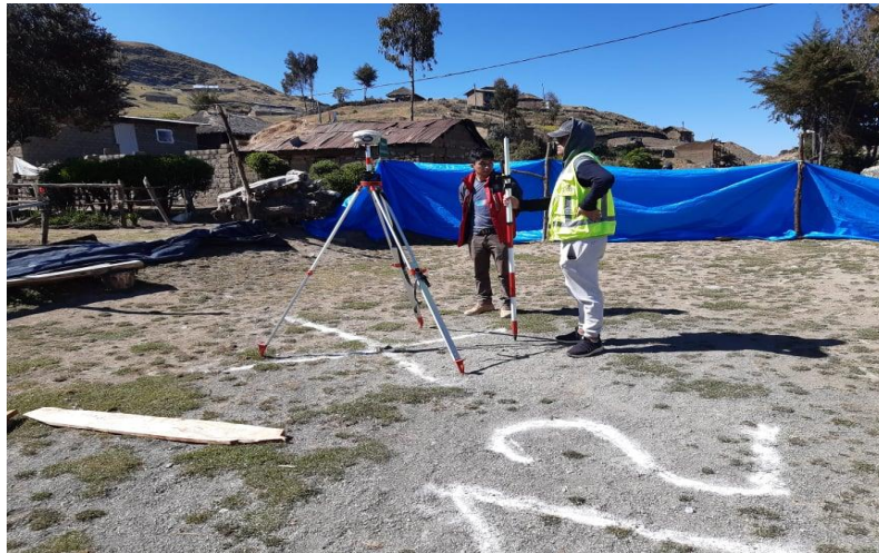
Figura 13. Ubicación de los puntos de control antes de realizar el vuelo con el Drone
