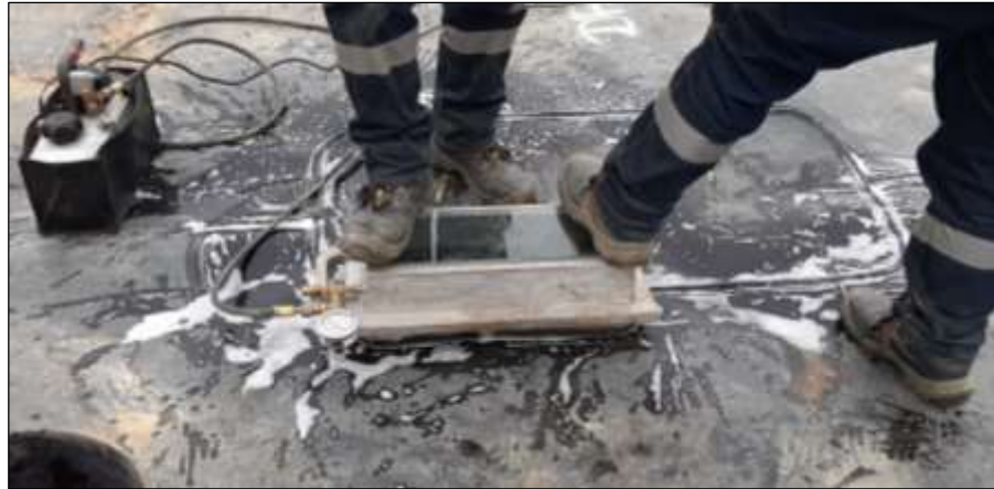
Figura 67: Prueba de Vacío
