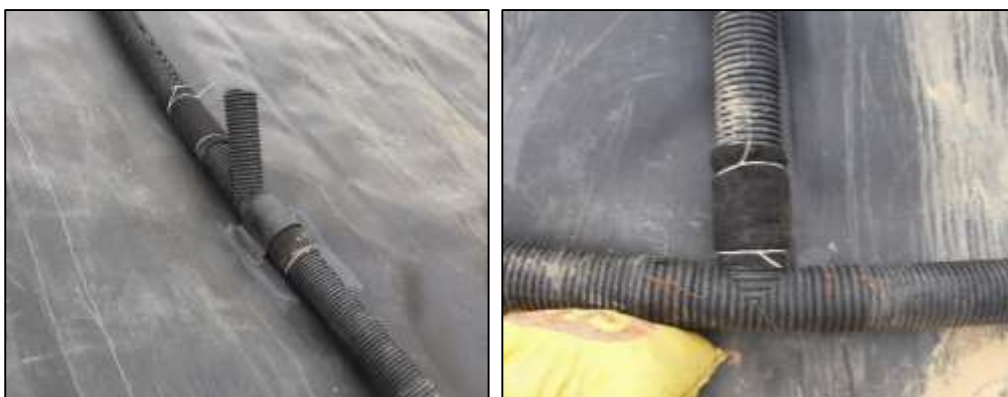
Figura 59: Ensamble de tubería corrugada
