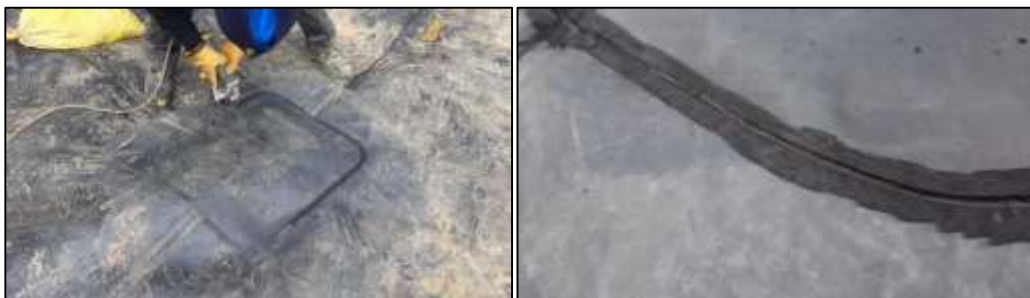
Figura 52: Lijado e incorporación de cable de cobre para termofusión por extrusión
