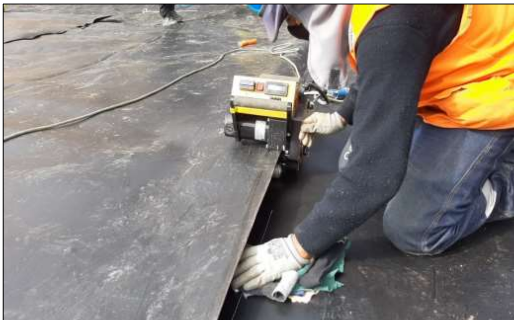
Figura 49: Soldadura con cuña caliente
