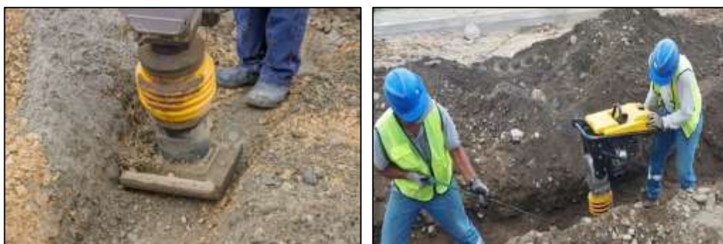
Figura 55: Compactación de zanjas de anclaje
