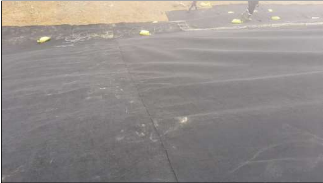
Figura 47: Termofusión con aire caliente
