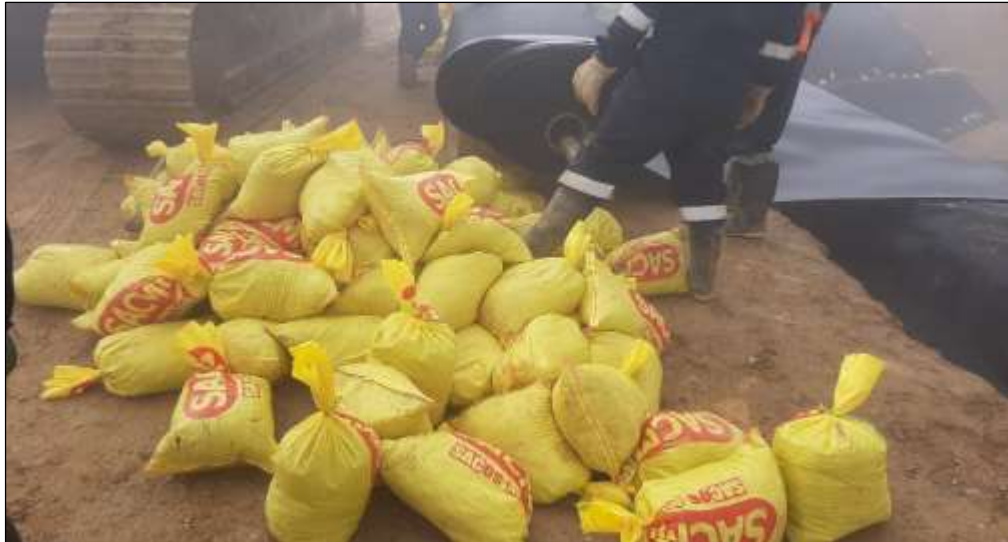
Figura 44: Preparación de saquillos miner para sujeción
