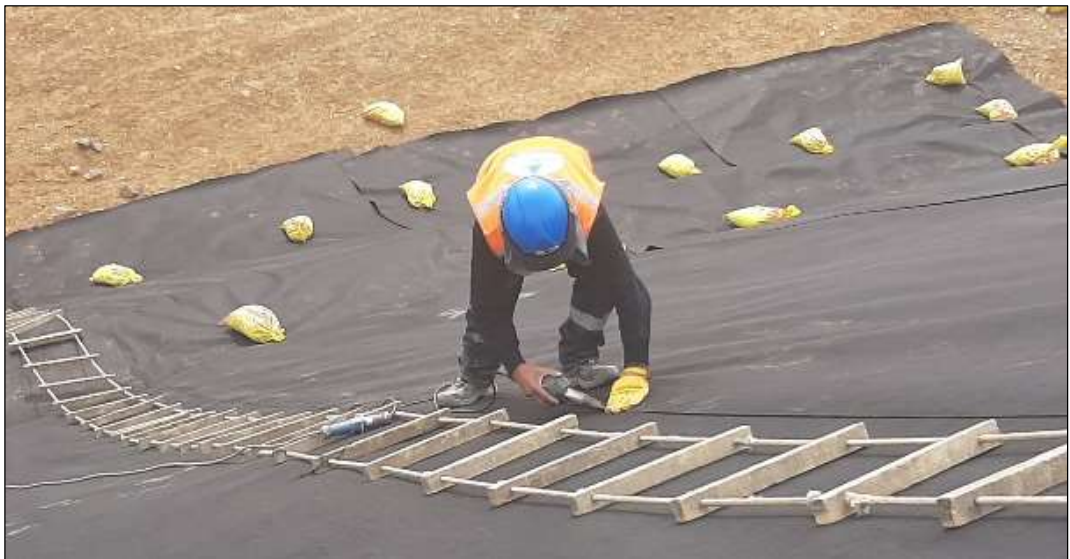
Figura 46: Termofusión con pistola de aire
