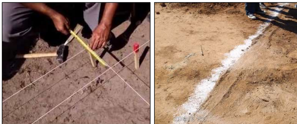
Figura 37: Trazo en superficie de terreno
