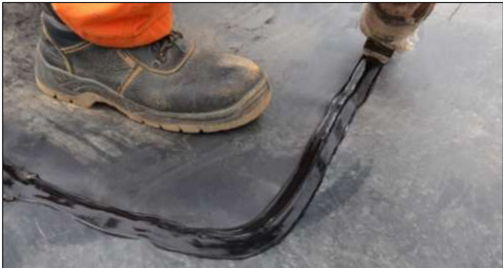
Figura 85: Soldadura con extrusora
