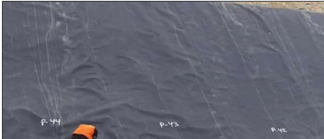
Figura 53: Codificación de paneles de geomembrana (Ejemplo)
