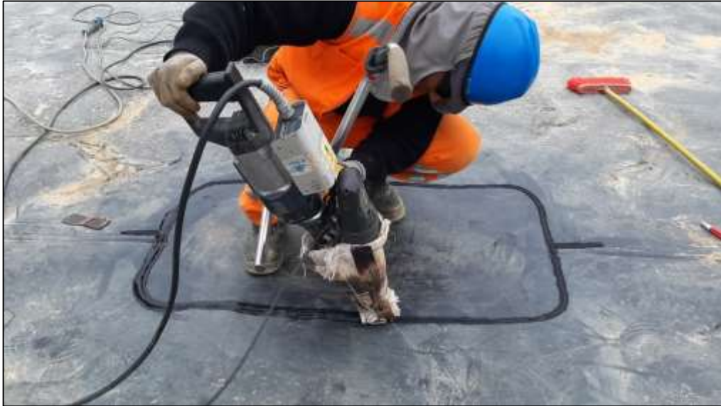
Figura 51: Soldadura por extrusión
