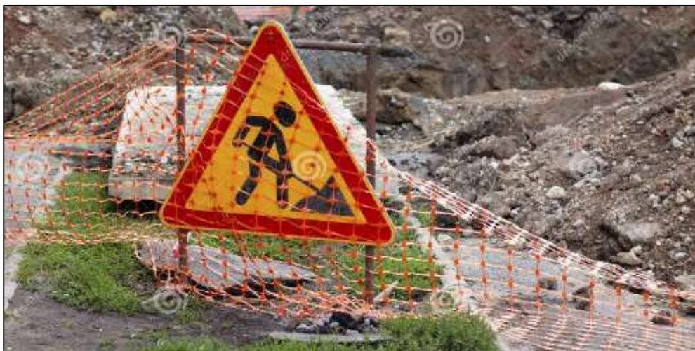
Figura 36: Señalización de seguridad
