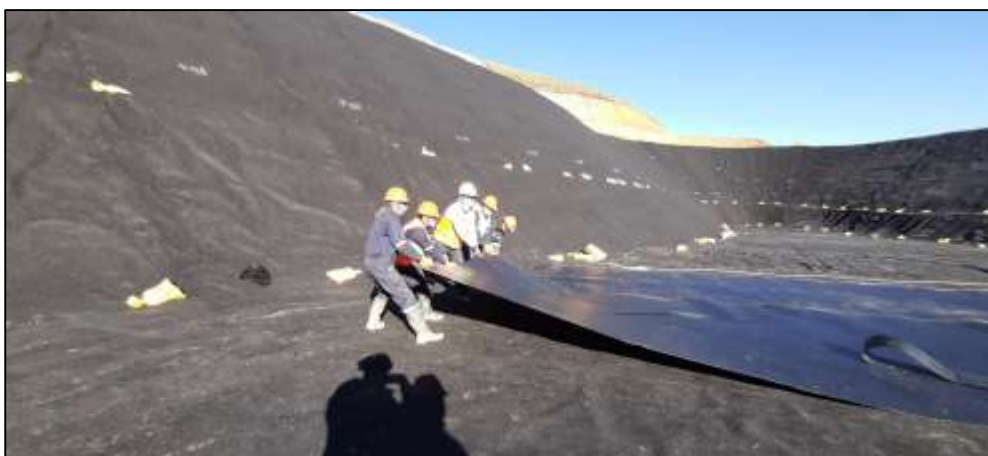
Figura 42: Despliegue y tendido de geomembrana
