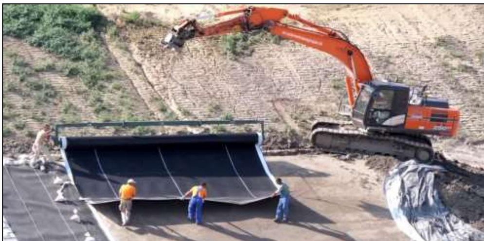
Figura 41: Despliegue de geotextil y geomembrana
