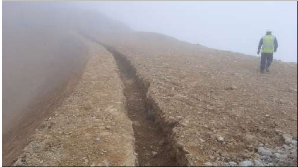
Figura 39: Zanja de anclaje
