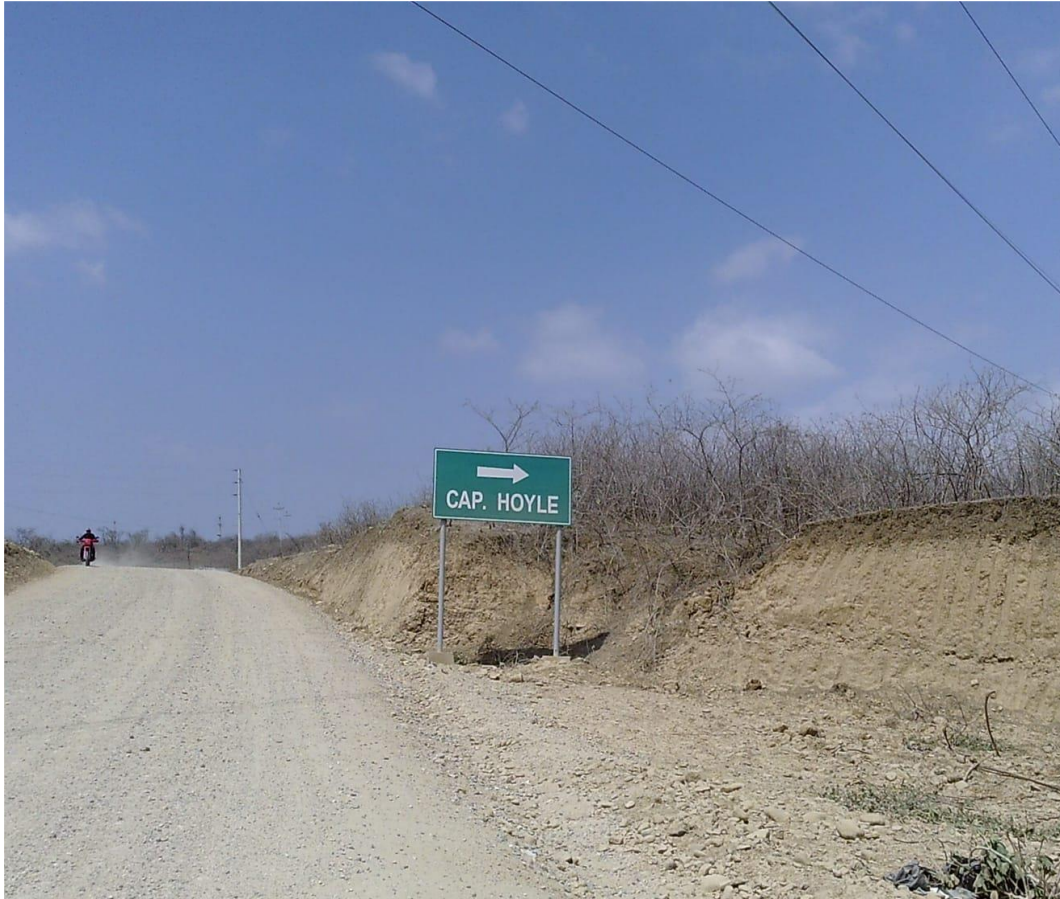
Figura 5. Carretera del CP. Cañaveral Tramo N°05 Fuente: Elaboración Propia
