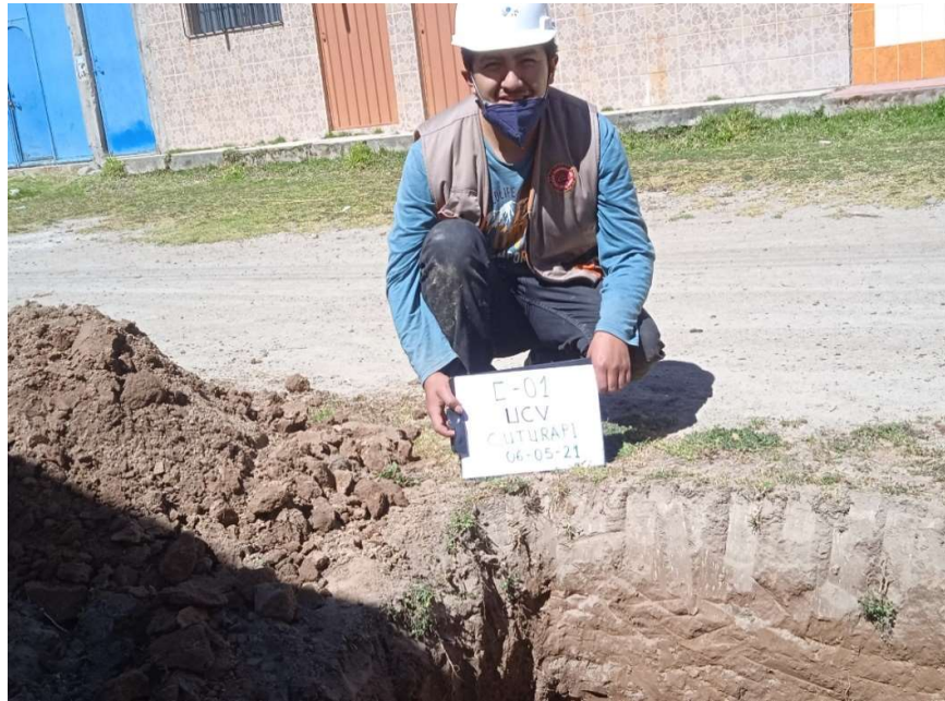
Figura 19. Ubicación de calicata N°01 en Jirón Yunguyo
