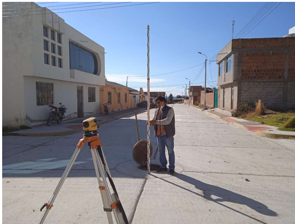
Figura 10. Nivelación de vías principales
