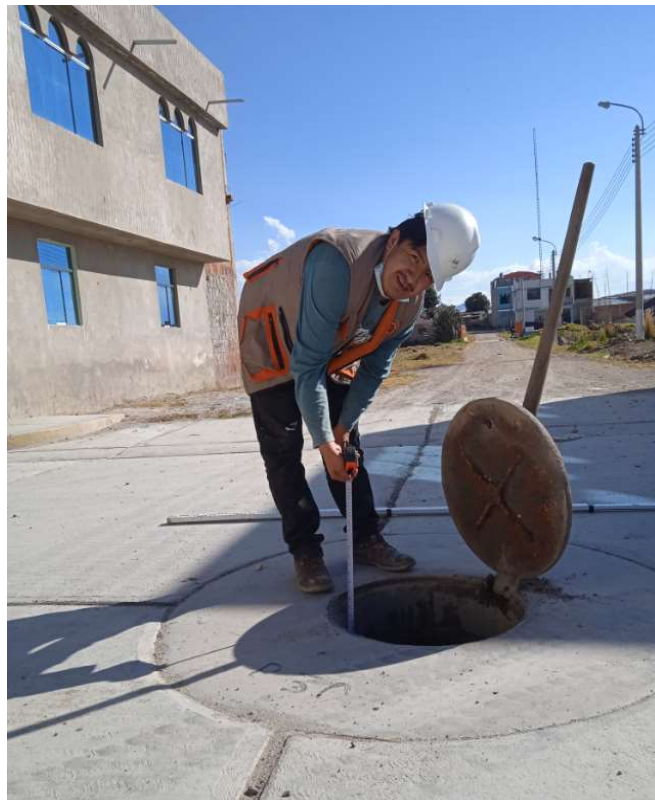
Figura 8. Verificación de cota fondo de buzones
