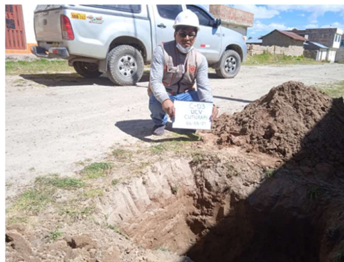
Figura 18. Nomenclatura correspondiente de la calicata excavada
