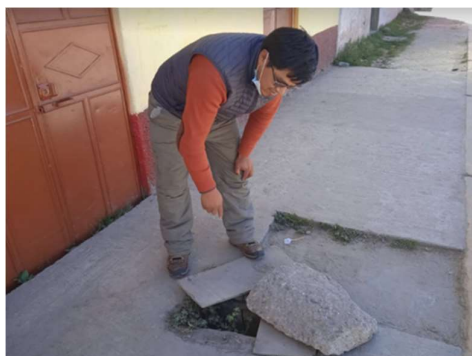
Figura 9. Situación actual de las conexiones domiciliarias
