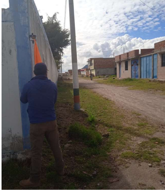
Figura 13. Ubicación de puntos referenciales con estación total
