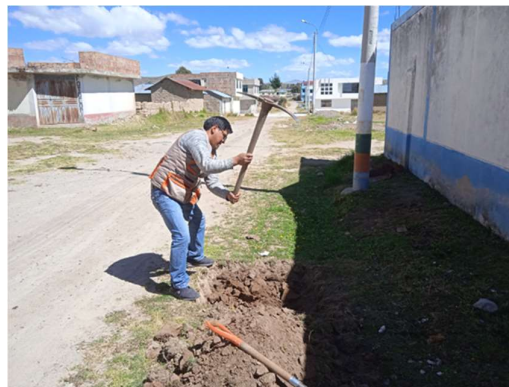
Figura 17. Excavación de calicatas
