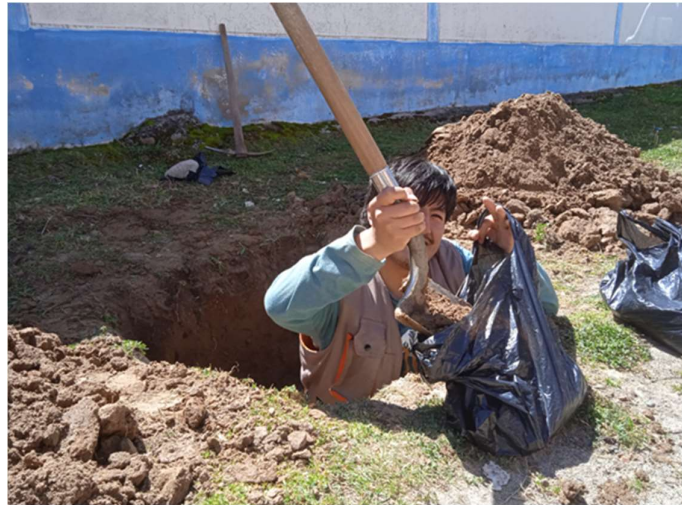
Figura 19. Extracción de material para su análisis en laboratorio
