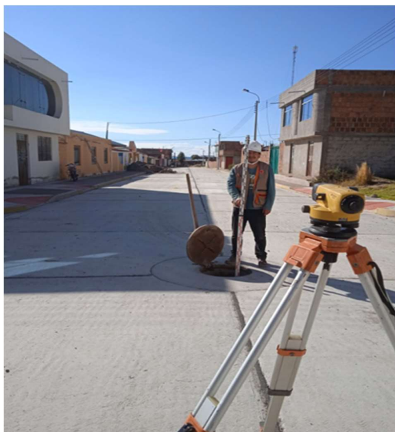
Figura 16. Equipo técnico durante la nivelación
