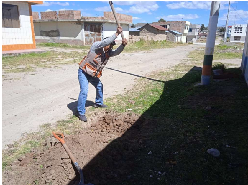
Figura 18. Excavación de calicatas
