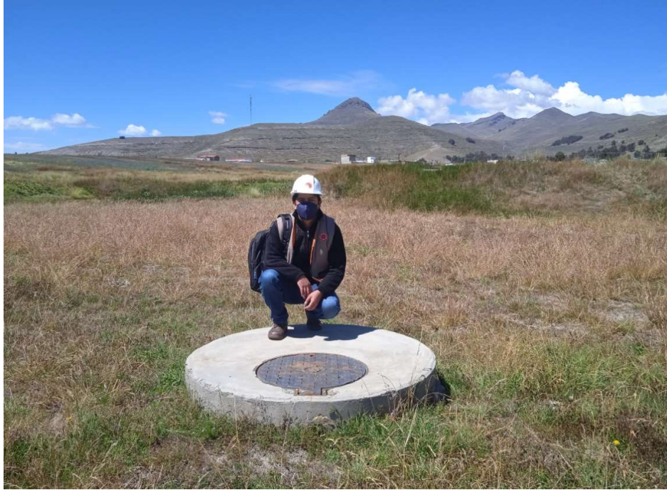
Figura 15. Ubicación del buzón existente N°74 (con presencia de aguas residuales)
