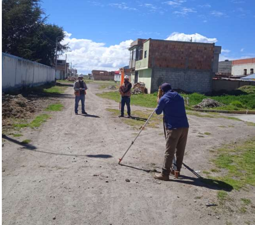
Figura 11. Recolección de datos con estación total
