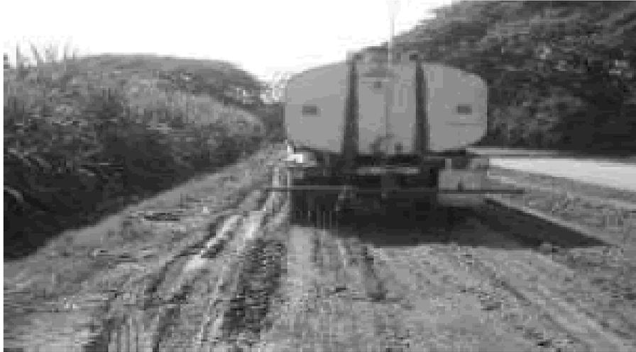
*Figura 3.* Estabilización de suelos con cloruro de calcio
