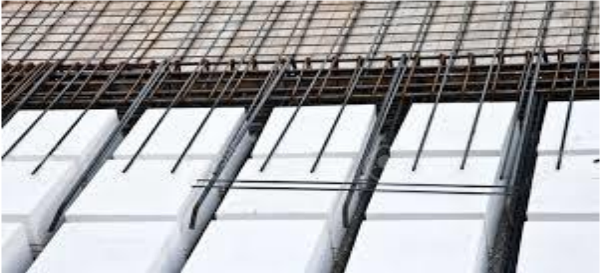
Figura 3 Sistema de viguetas pretensadas
