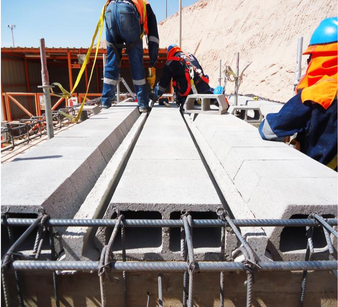
Figura 15 Trabajando con las viguetas pretensadas
