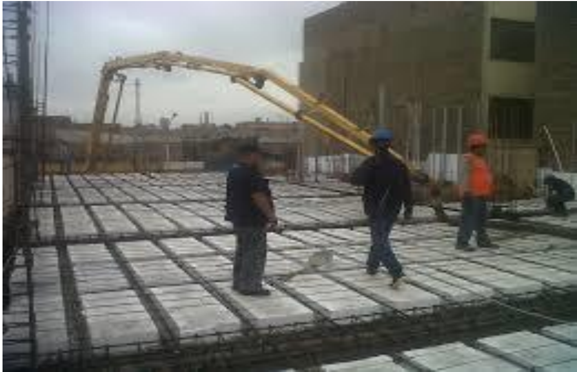
Figura 2 Construcción con viguetas pretensadas
