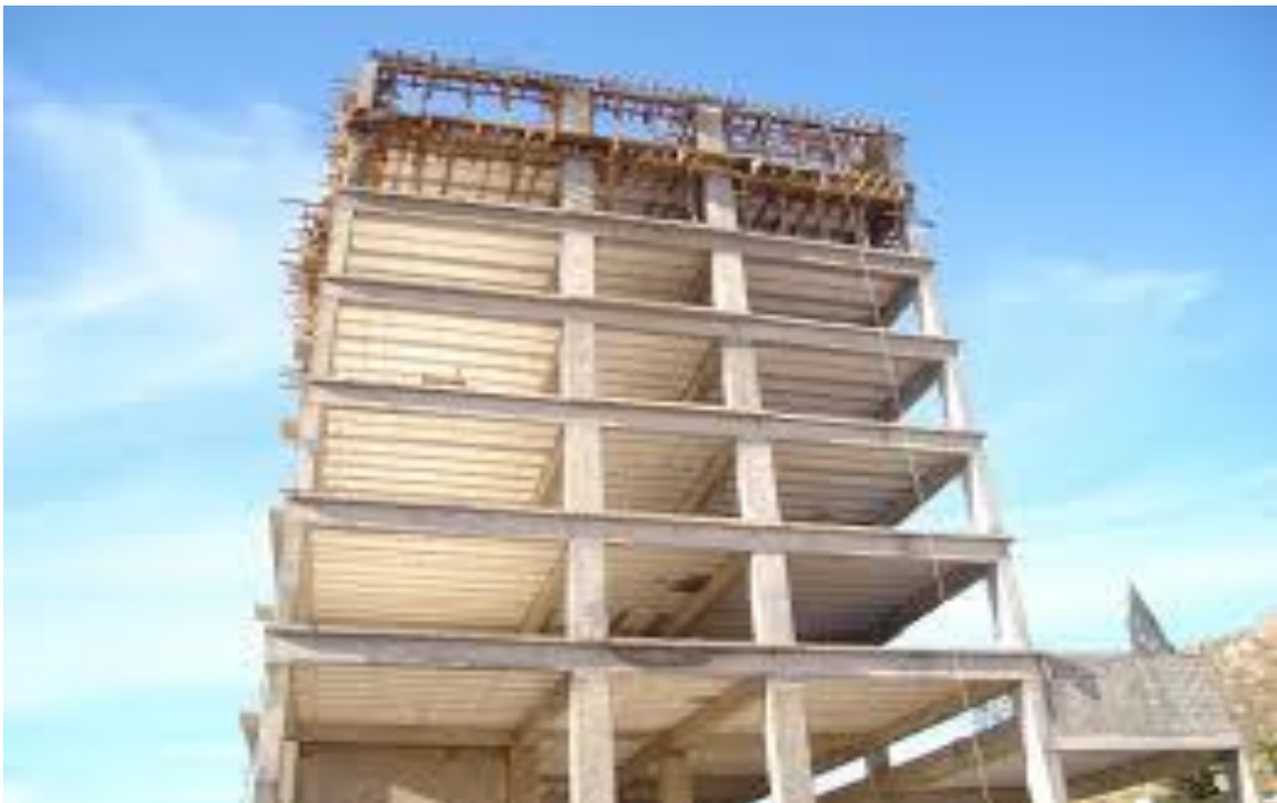
Figura 44 Edificación con viguetas pretensadas
