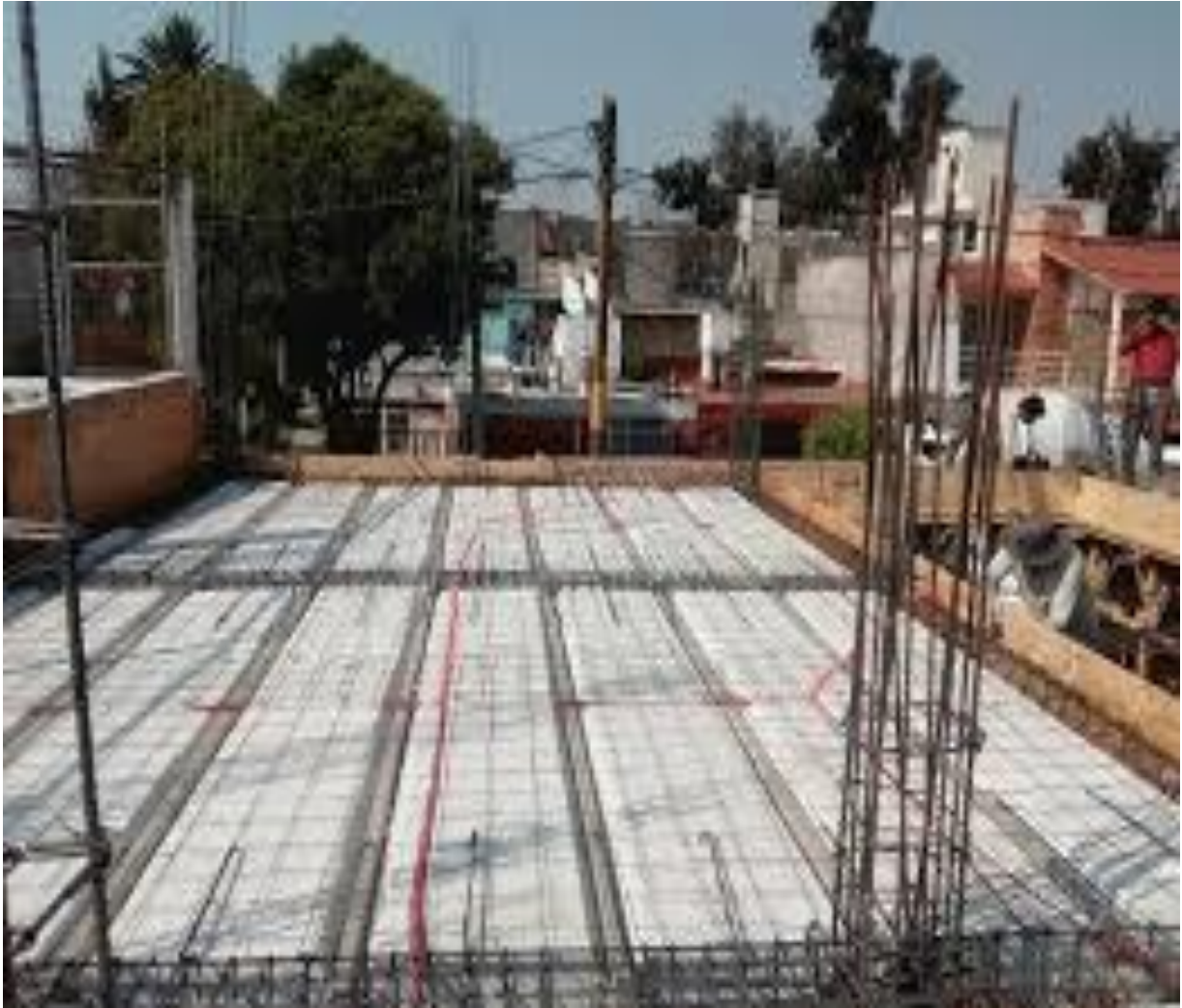
Figura 4 Viguetas pretensadas
