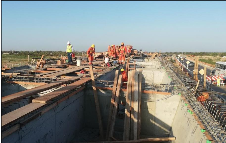
**Figura 92.** Desencofrado de tapas exteriores e interiores.
