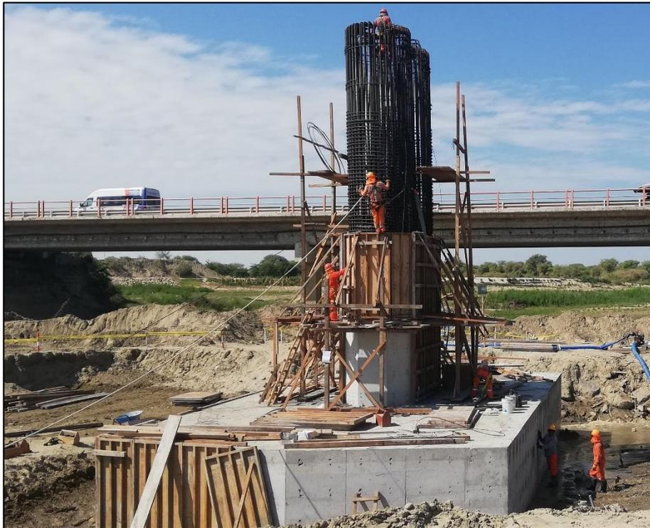
**Figura 63.** Vertido de concreto en columna de pilar, por etapas.
