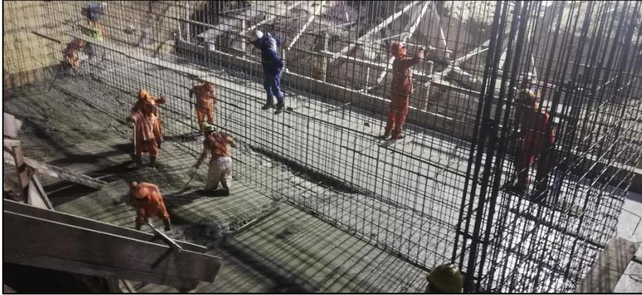
**Figura 54.** Vestido de concreto en zapata de estribo.
