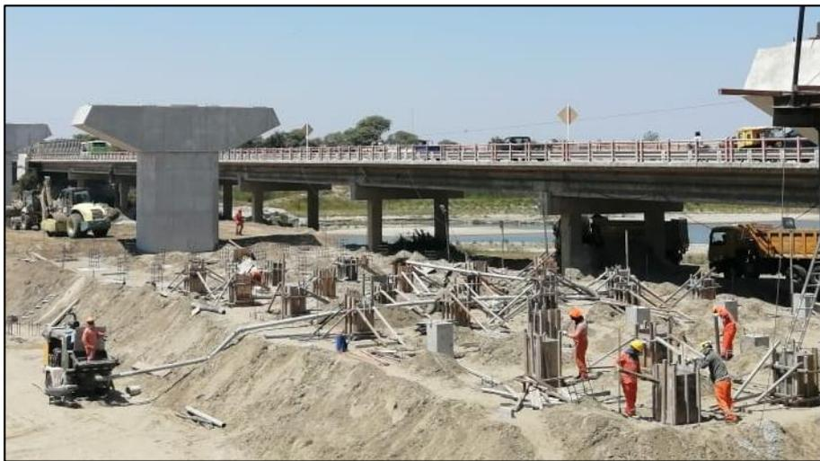
**Figura 75.** Vertido de concreto en pedestales.
