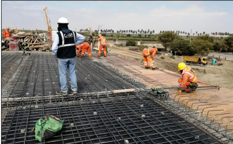
Armatura de fierro en la losa superior
