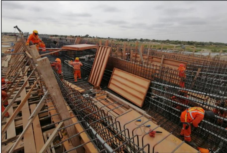
**Figura 88.** Encofrado de tapas exteriores e interiores.
