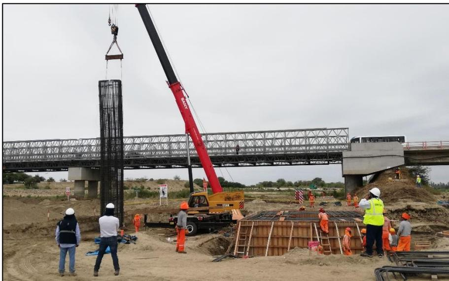
**Figura 61.** Izado de armadura de refuerzo para columna de pilar.
