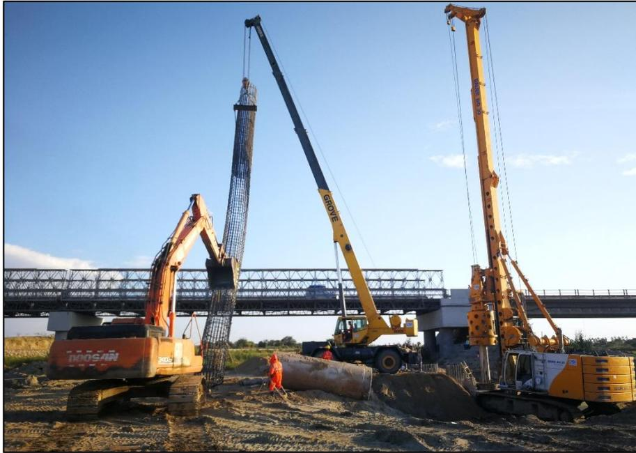
**Figura 36.** Izado de armadura para pilote.
