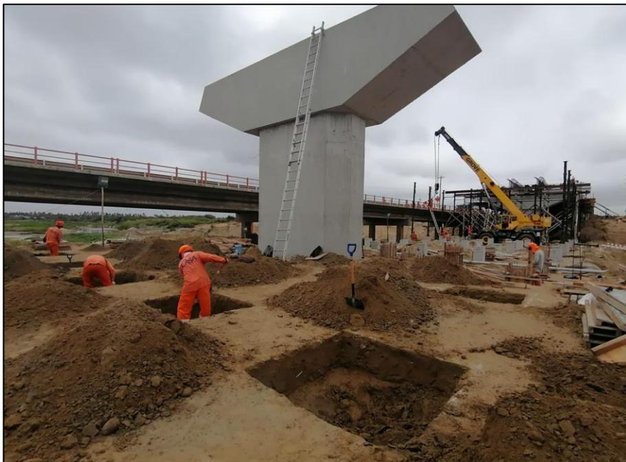
**Figura 71.** Excavación para zapata para pedestales.
