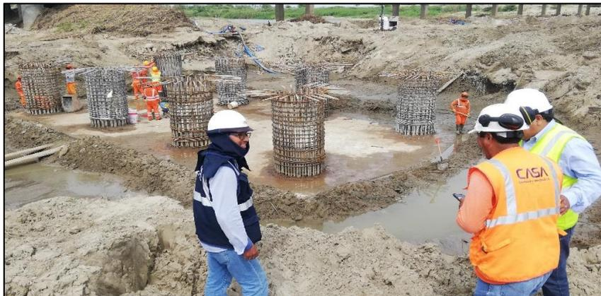
**Figura 58.** Limpieza de solado para iniciar con la armadura en zapata.
