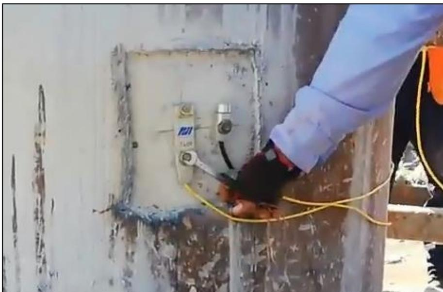
**Figura 48.** Instalación de sensores acelerómetro y deformímetro.
