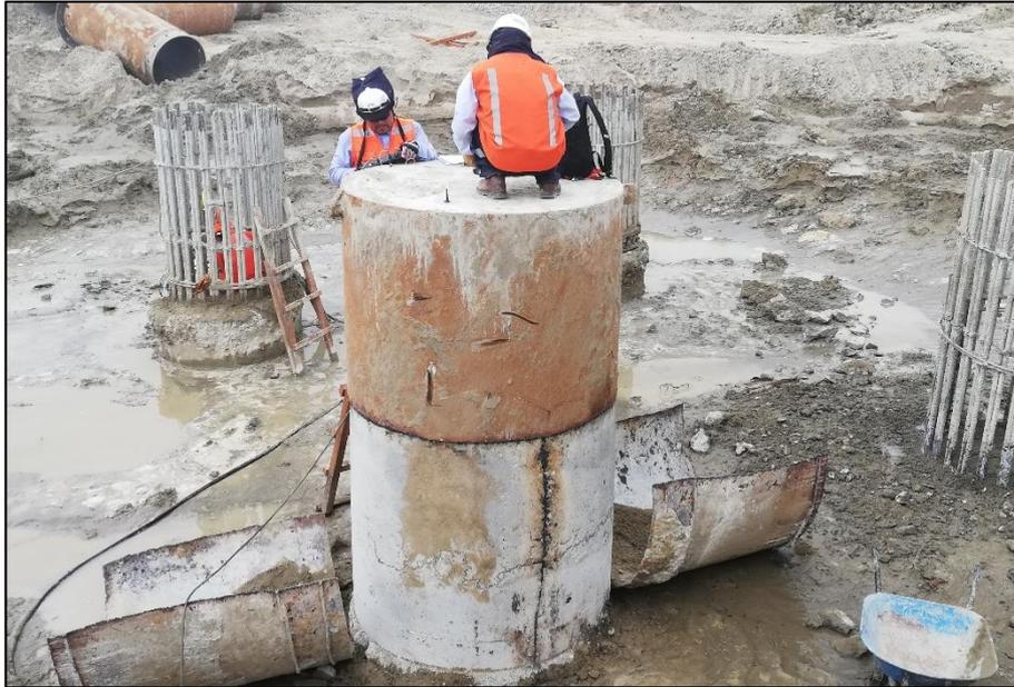
**Figura 39.** Pilote destinado para prueba de carga dinámica.
