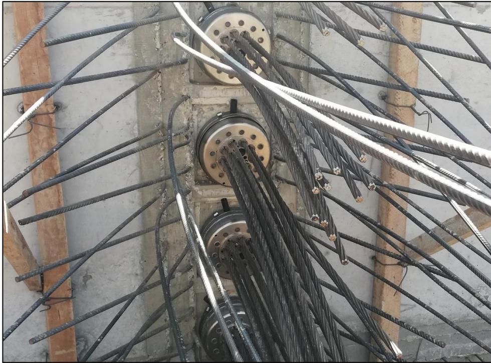
**Figura 97.** Cables preparados para su postensado.
