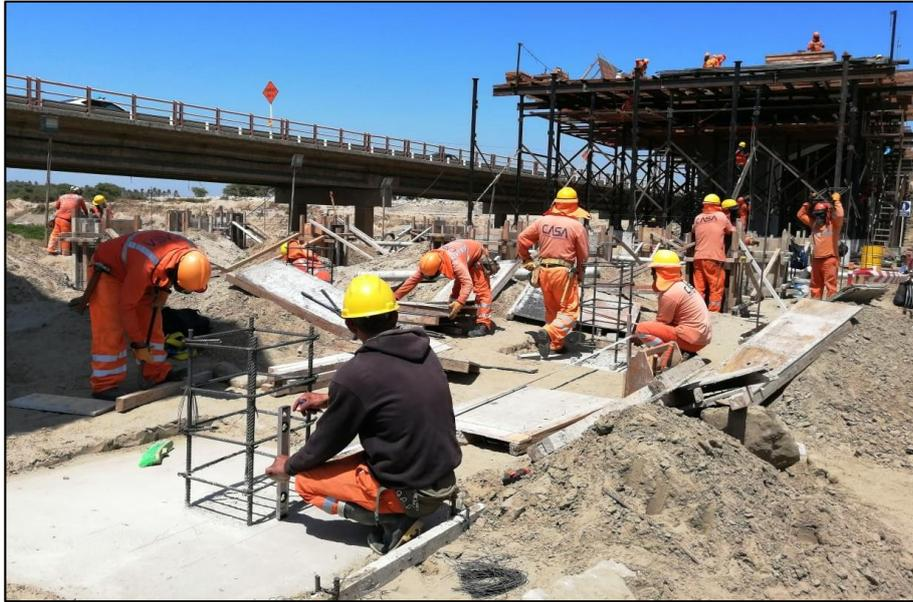
**Figura 74.** Encofrado de pedestales.
