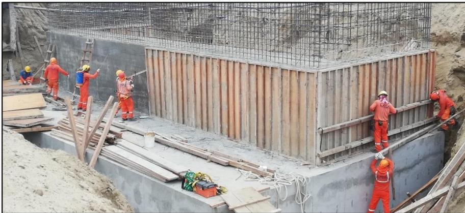
**Figura 55.** Vertido de concreto en muro de estribo, por etapas.
