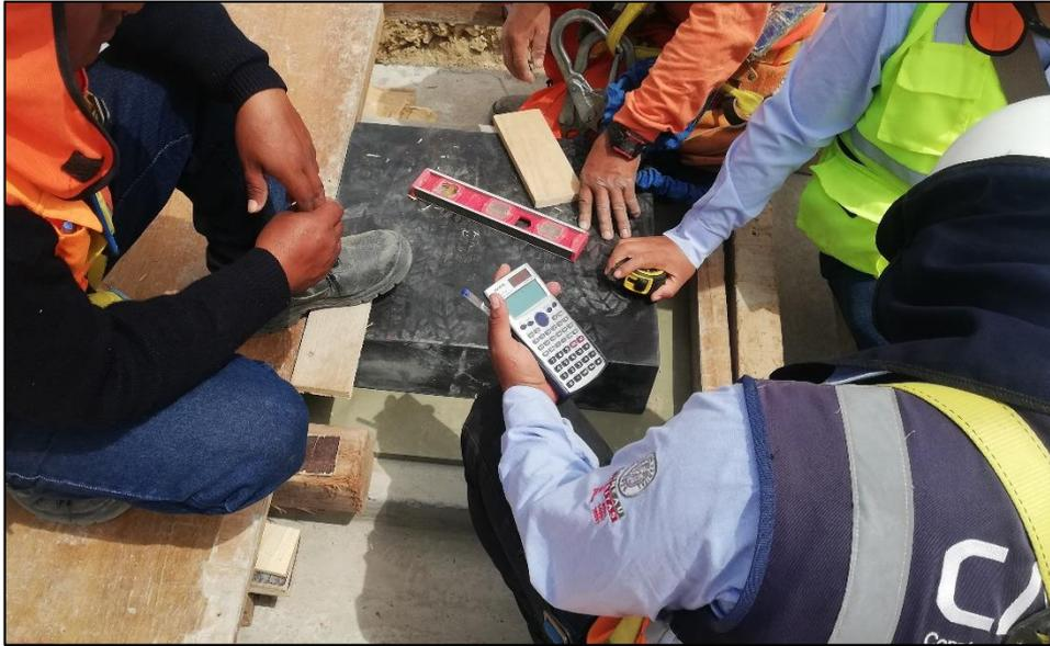
Instalación de dispositivos de apoyo juntamente con supervisión
