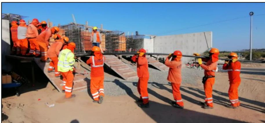
**Figura 87.** Colocación de cables de postensado.
