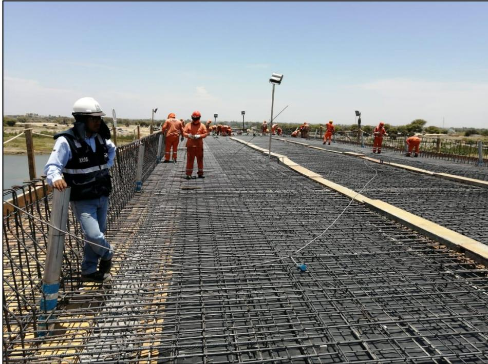
**Figura 94.** Acero de refuerzo en losa superior.
