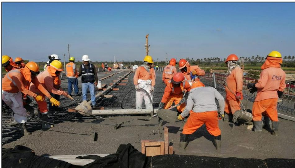
**Figura 95.** Vertido de concreto en losa superior.
