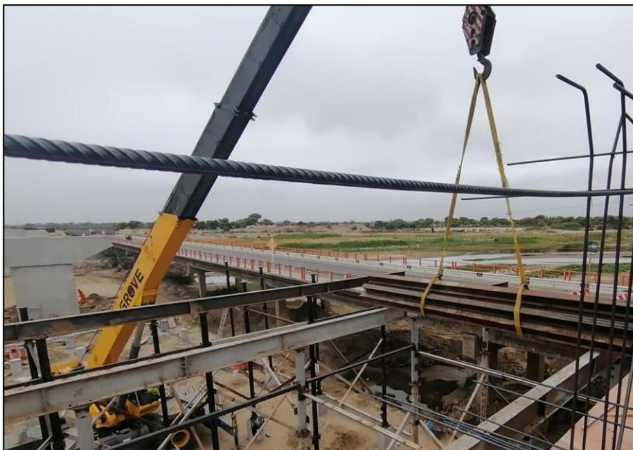
**Figura 79.** Izado de vigas secundarias.
