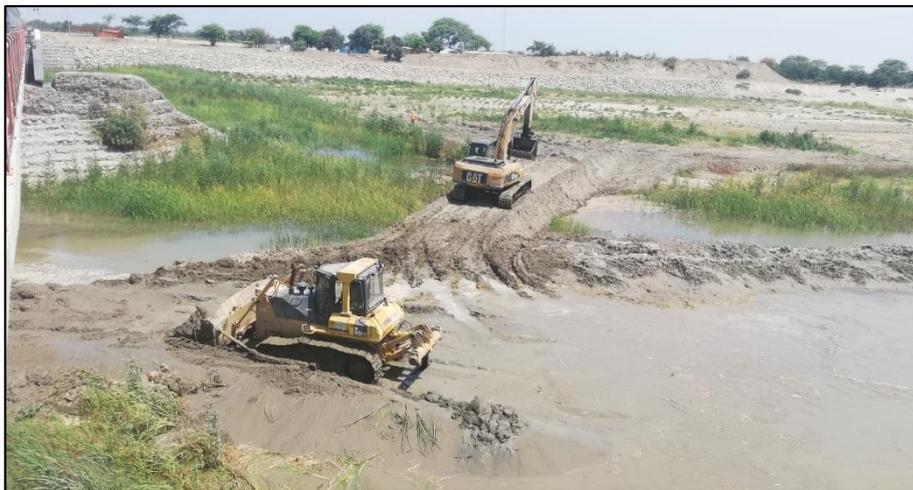
**Figura 30.** Limpieza de terreno y fajas laterales.
