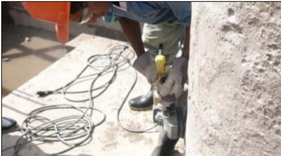
**Figura 47.** Preparación de pilote para instalar sensores.
