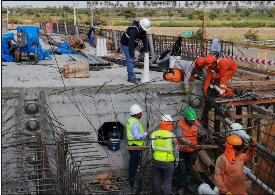
Colocación de cables para un siguiente tramo, juntamente con supervisión
