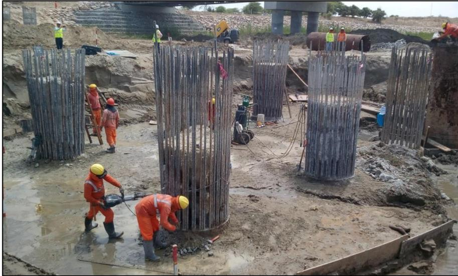
**Figura 41.** Descabezado de pilotes.
