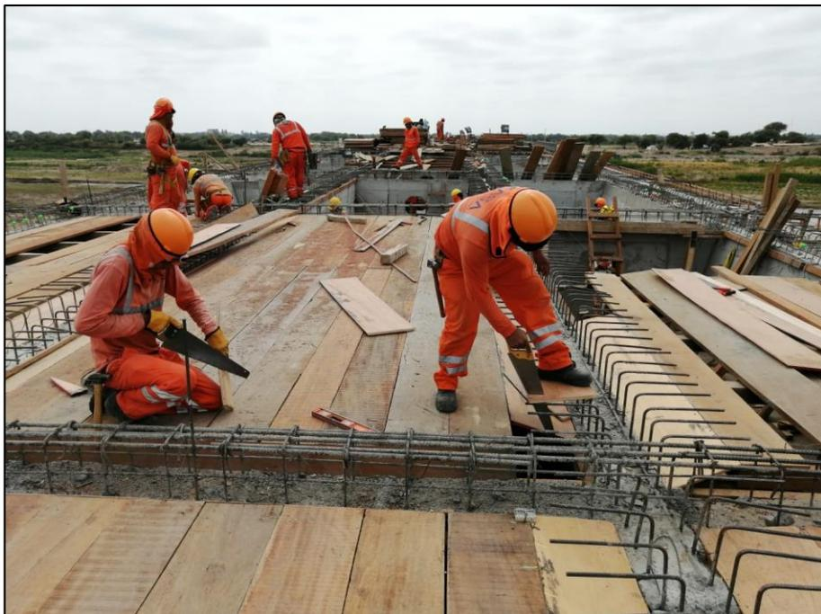
**Figura 93.** Encofrado de losa superior.
