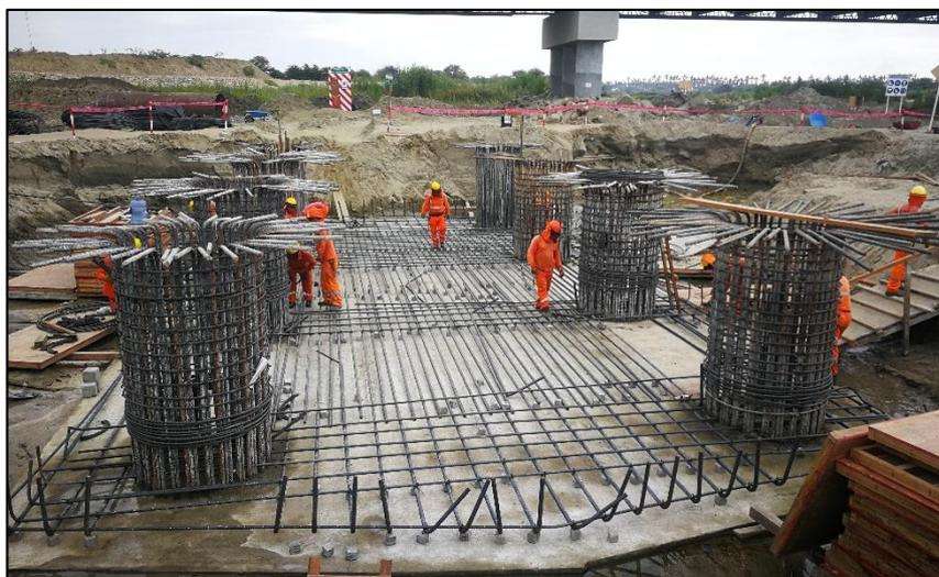
**Figura 59.** Armadura en zapata de pilar.
