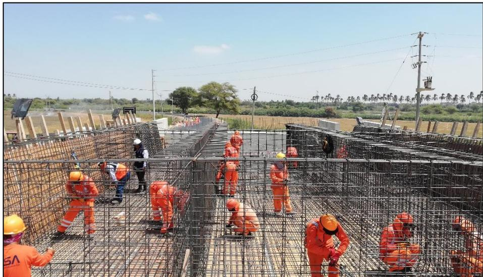
Armadura de hierro en losa inferior y vigas
