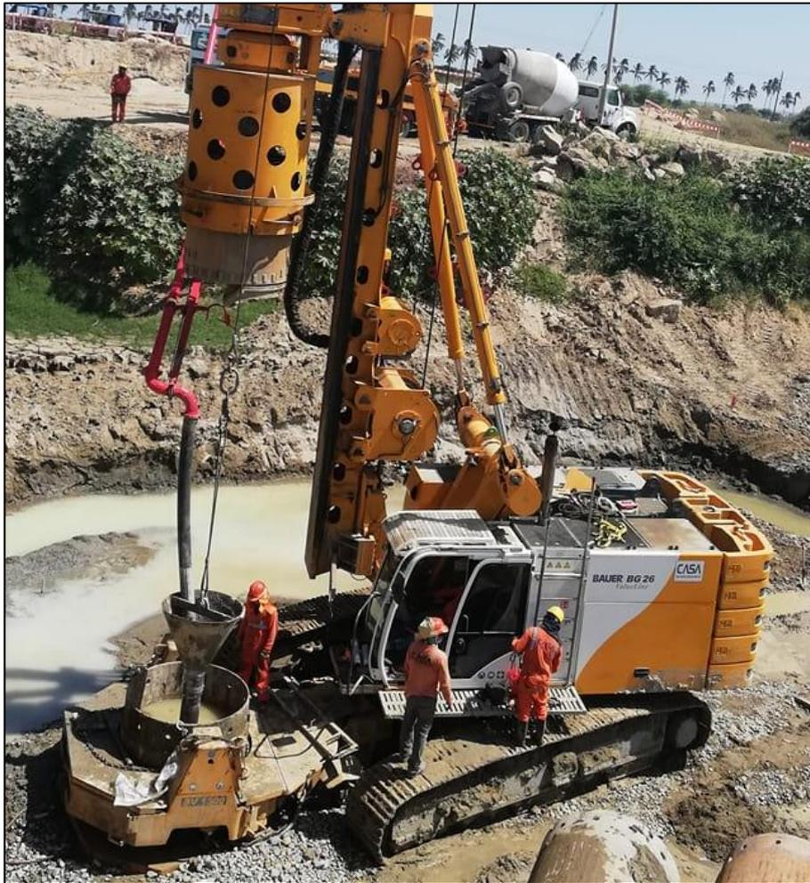
**Figura 38.** Vertido de concreto en pilote con bomba de concreto
