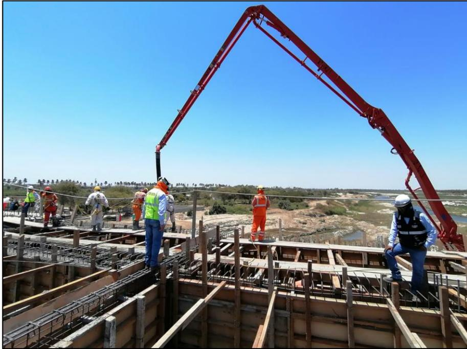
**Figura 90.** Vertido de concreto en almas.
