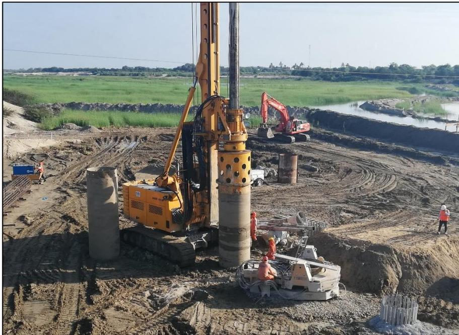
**Figura 35.** Piloteadora con sus complementos de perforación.
