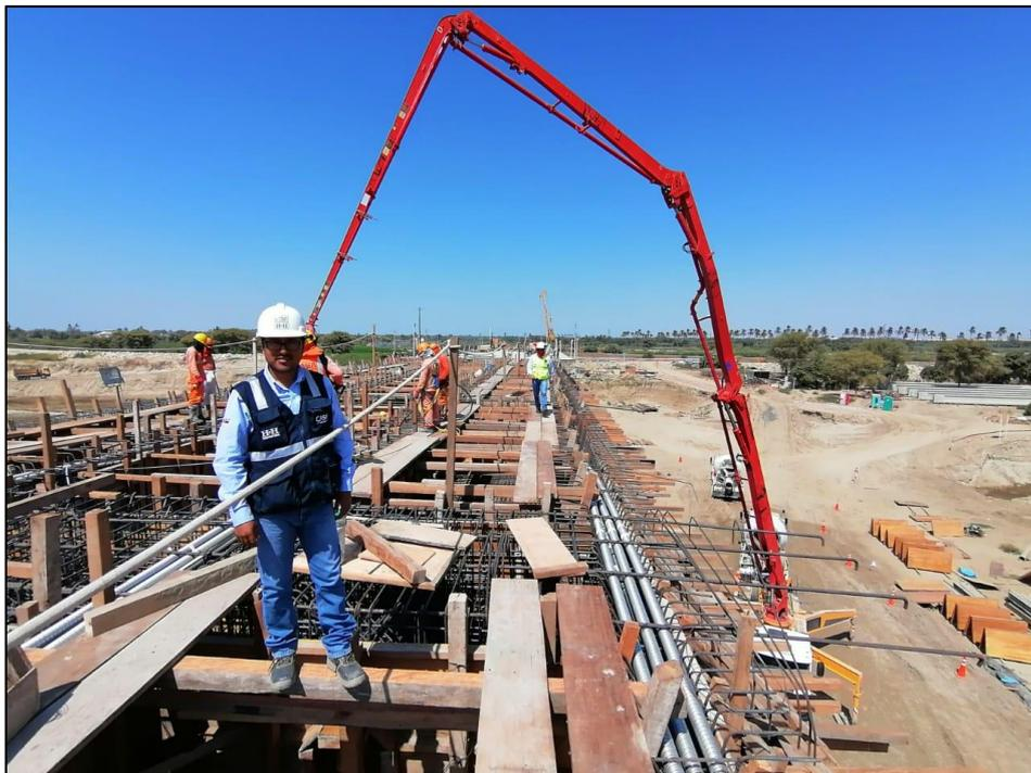
**Figura 89.** Vertido de concreto en losa inferior.
