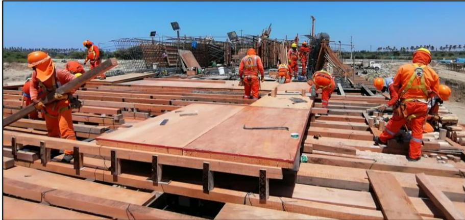
**Figura 83.** Panel de Triplay en la base de losa inferior.
