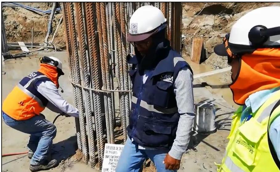
**Figura 43.** Preparación de pilotes para pruebas PIT
