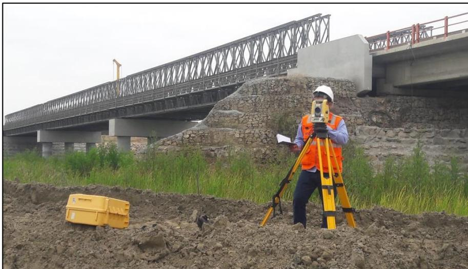
**Figura 28.** El topógrafo colocando de MB's auxiliares.
