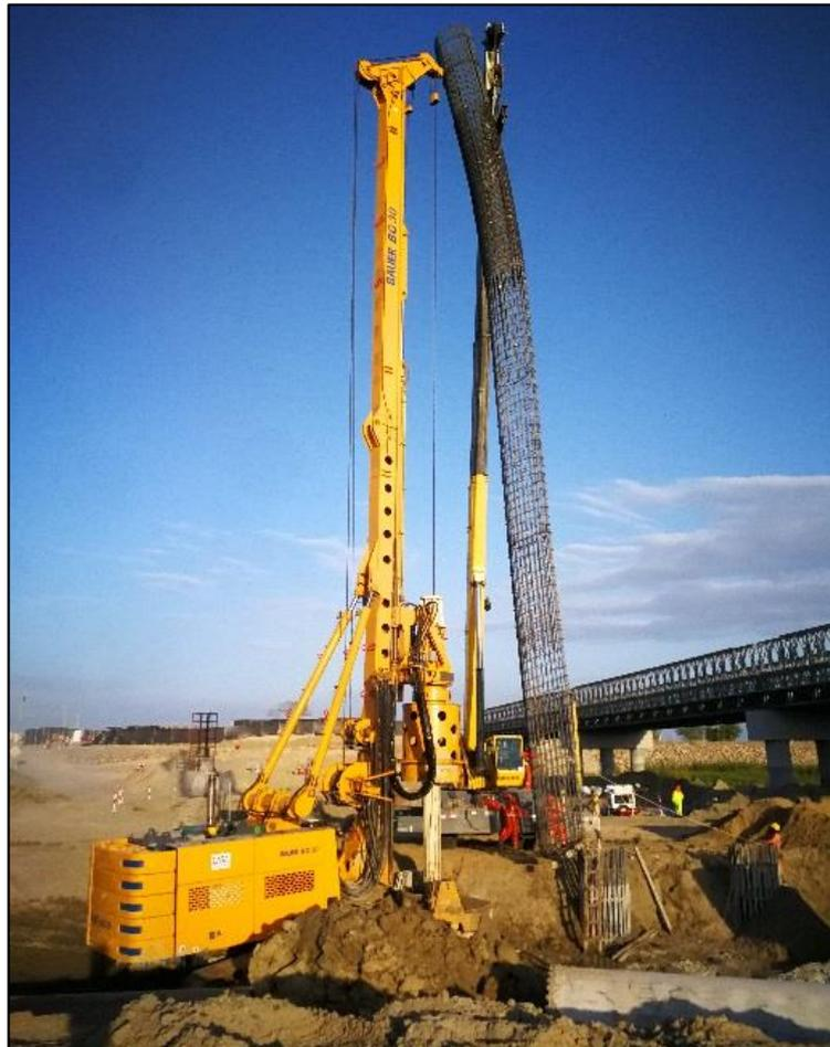
Izado de armadura para pilotes.
