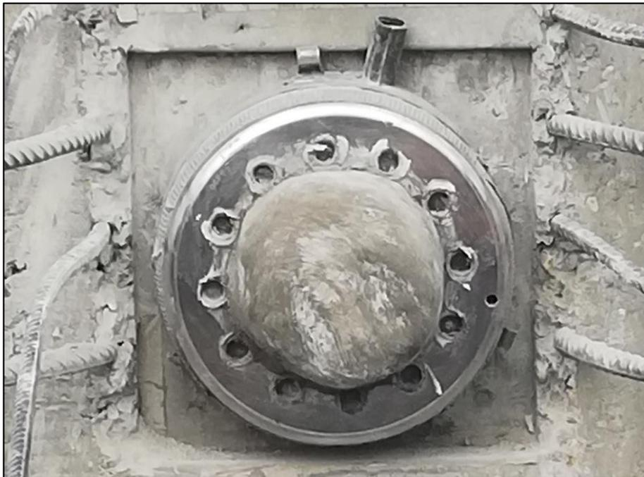
**Figura 100.** Sellado de cables, después de su corte.
