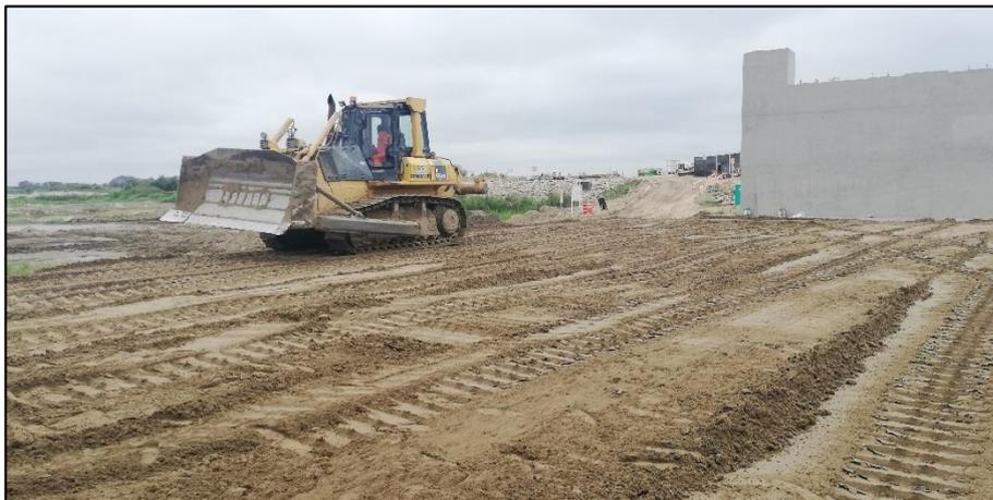
**Figura 67.** Conformación de terraplén para la plataforma de falso puente.
