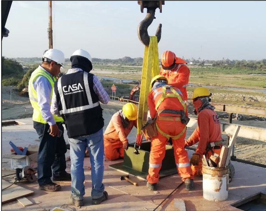
Instalación de dispositivo sísmico en diafragma juntamente con supervisión
