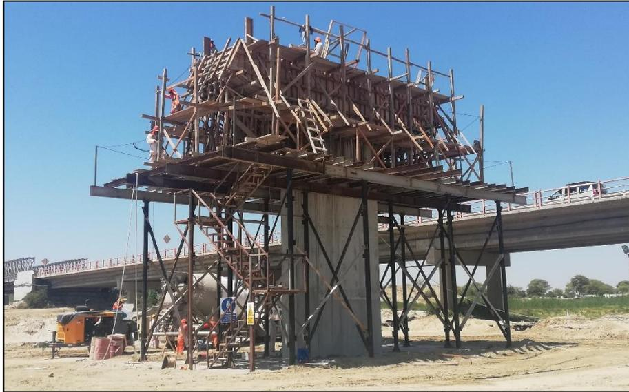
**Figura 64.** Encofrado y vertido de concreto en viga cabezal de pilar.
