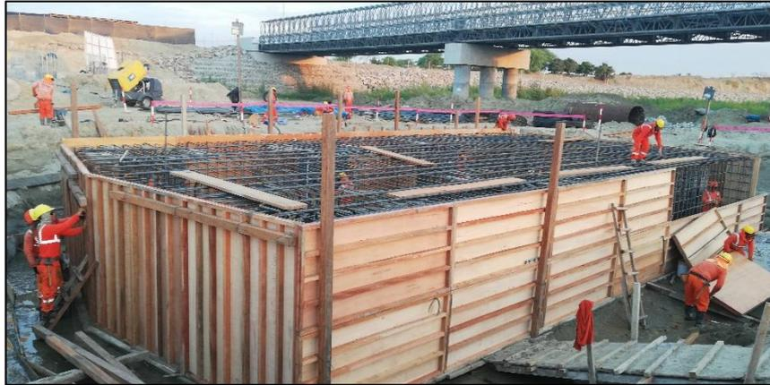
**Figura 60.** Encofrado en zapata de pilar.
