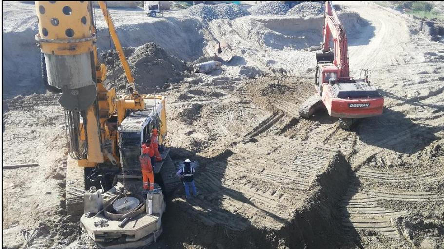
**Figura 31.** Plataforma de trabajo para pilotes.
