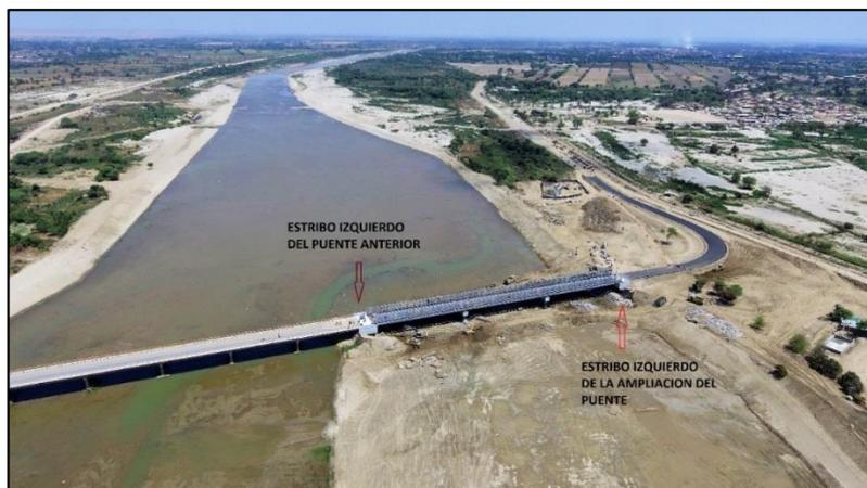
**Figura 1.** Ampliación del anterior puente Independencia con estructura Bailey
