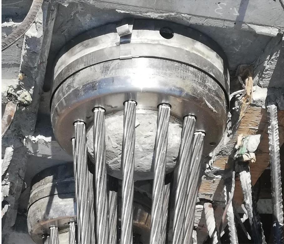
**Figura 101.** Continuación de cables para el siguiente tramo.
