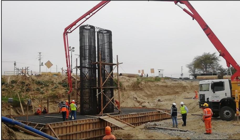
**Figura 62.** Vertido de concreto en zapata de pilar.
