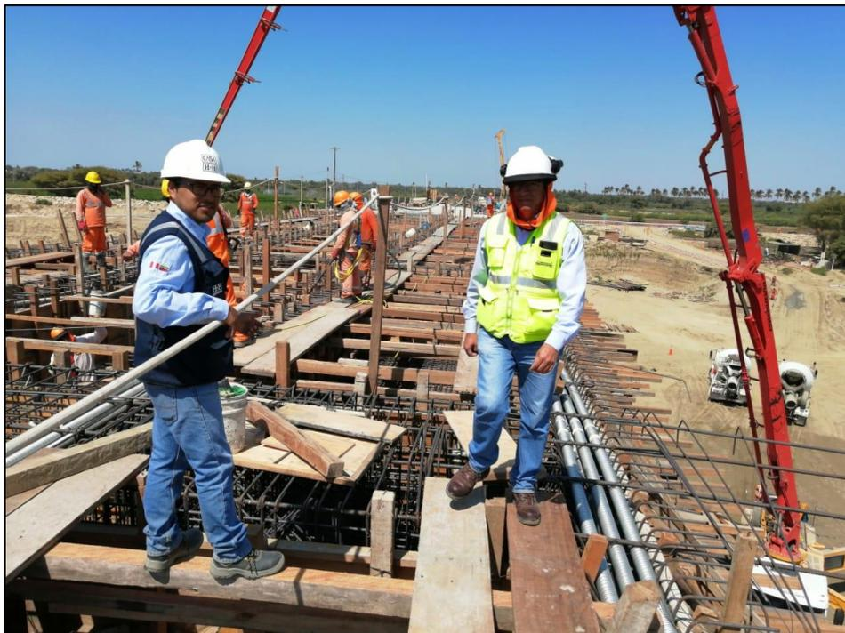
Con el supervisor en el vertido de concreto de losa inferior y vigas
