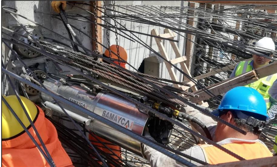
**Figura 99.** Postensado de vigas
