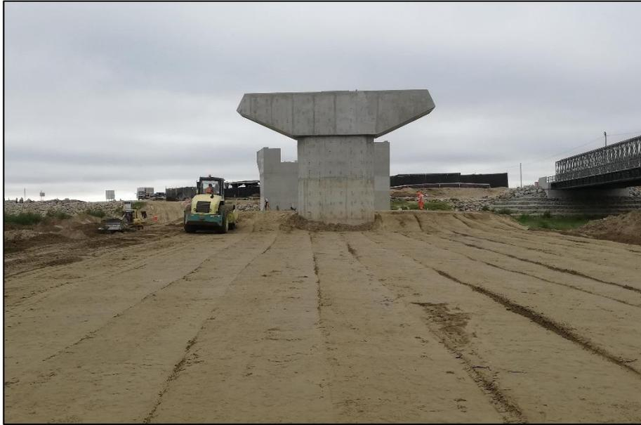
**Figura 68.** Compactado de terraplén para la plataforma de falso puente.
