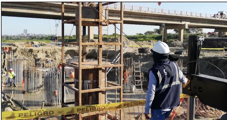
**Figura 53.** Golpes en el pilote y control de asentamiento.
