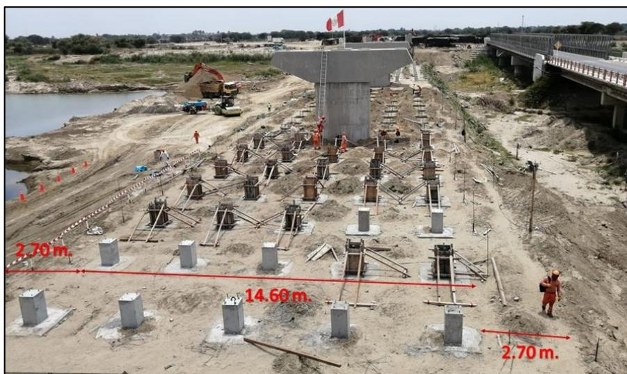
**Figura 69.** Dimensiones de plataforma para falso puente.
