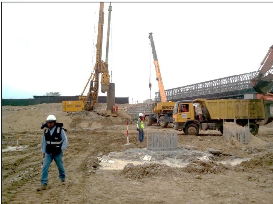
Trabajos de pilotaje en estribo izquierdo, pilotes concluidos en pilar 1
