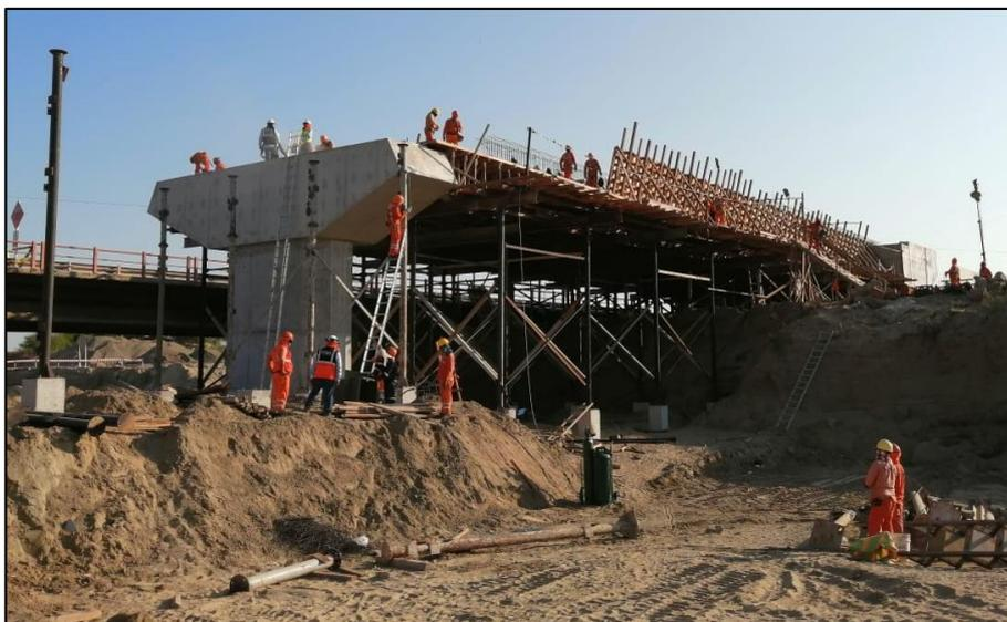
**Figura 77.** Iniciando el falso puente en el estribo derecho.
