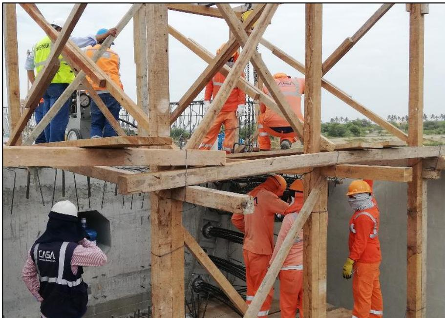
**Figura 98.** Preparando andamio y personal para postensado
