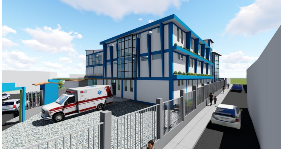
Vista externa de la zona de emergencia
