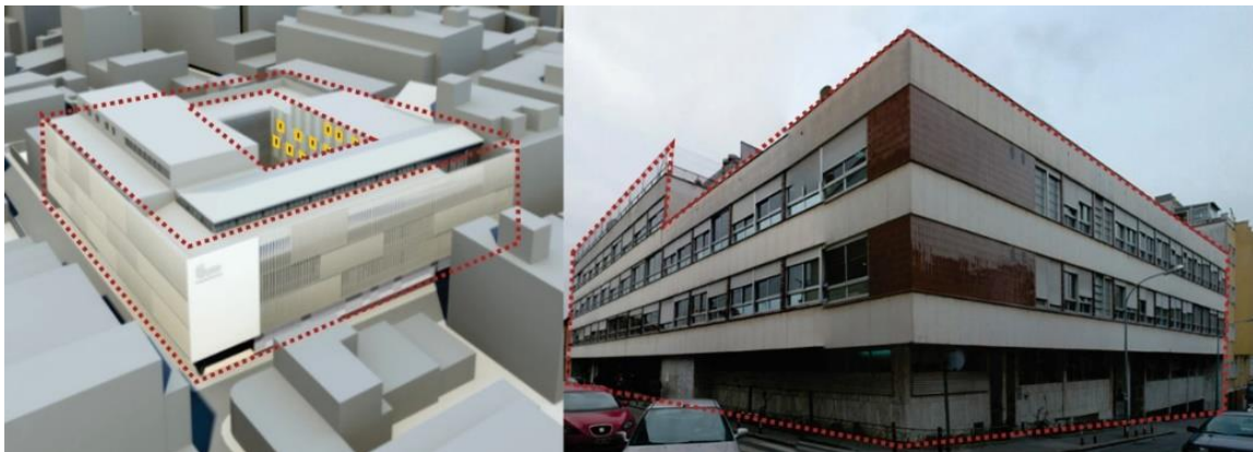
Fotografía 22. Antes y Después de Hospital Sociosanitario de Mollet
