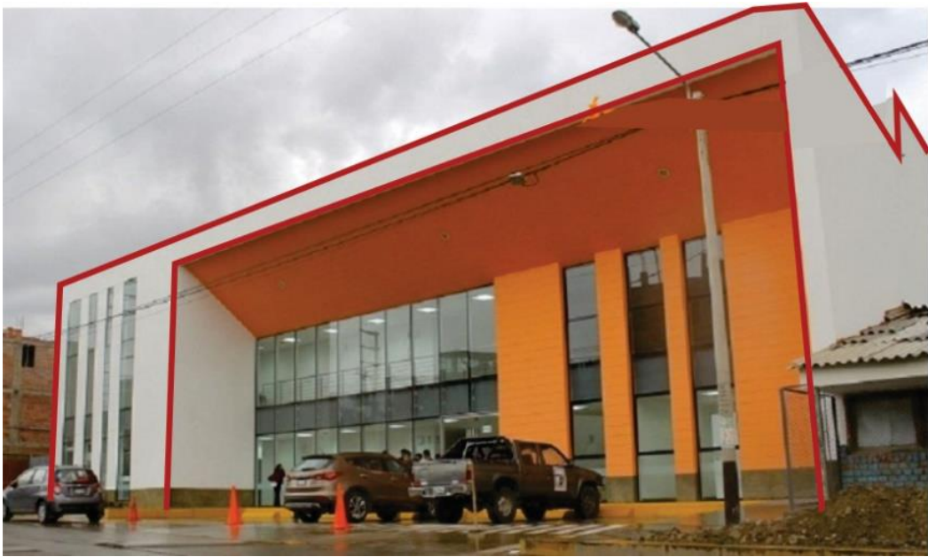
Fotografía 17. Vista de la fachada del Centro de Salud de Palmira
