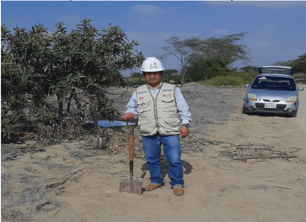
Foto 1: Apertura de calicata en la zona de trabajo
