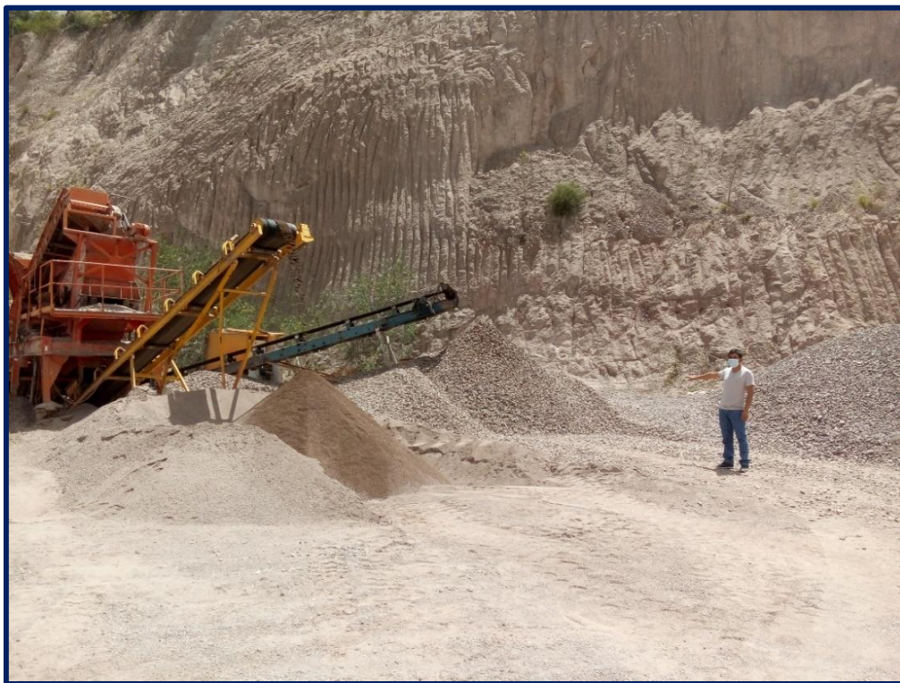
Imagen N° 2 Visita y cotización de chancado en la Cantera Cooper.
