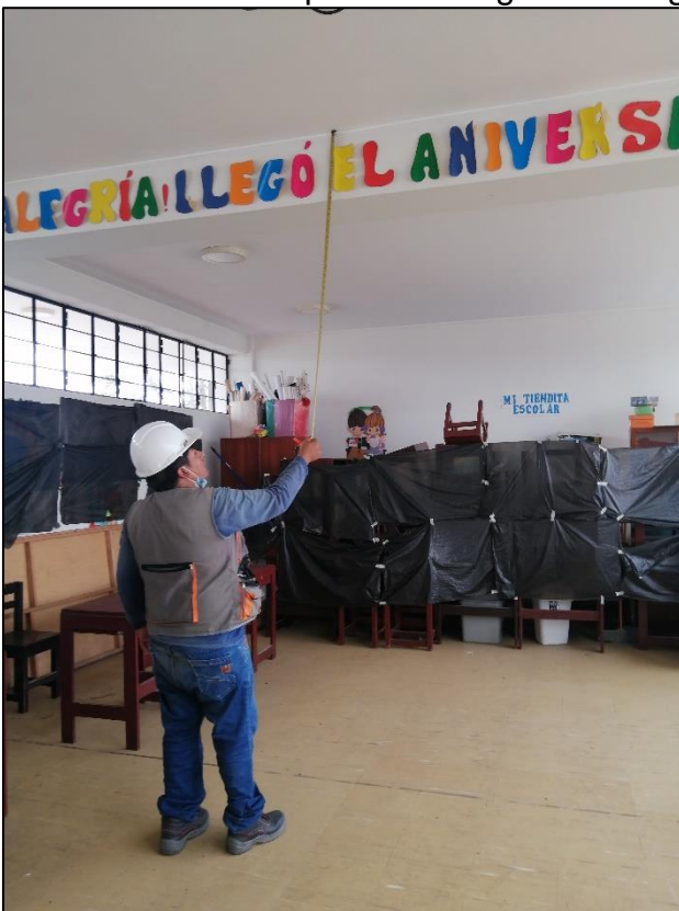
20. medición de peralte de viga en el segundo piso.
