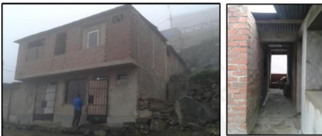
Figura 56. Vivienda de albañilería evaluada para aplicar un reforzamiento. Fuente: Tomado de Farje y Yabuta (2020).
