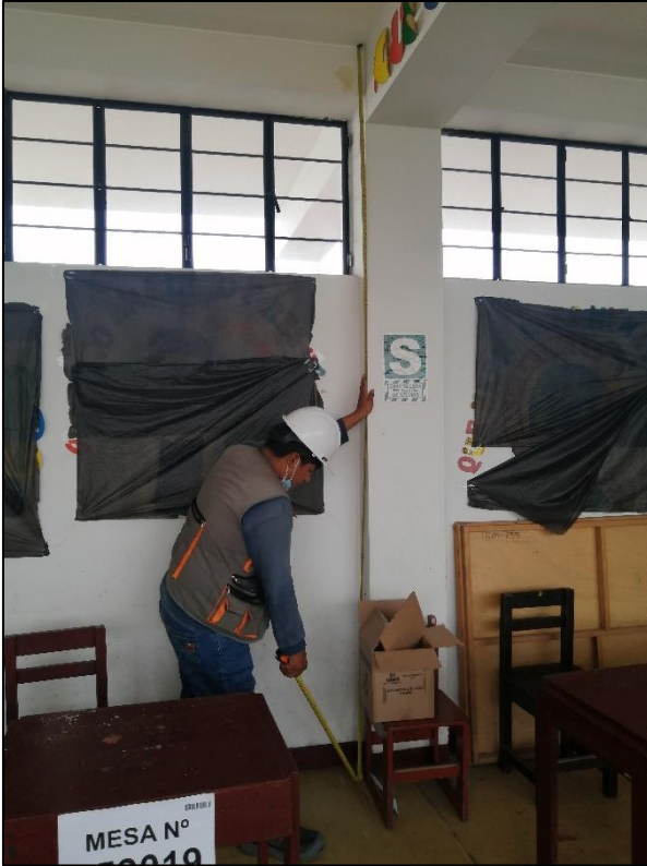
20. medición de peralte de viga en el segundo piso.
