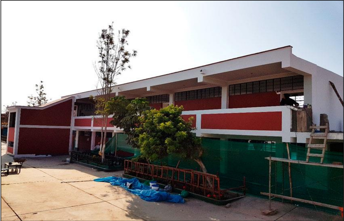
5. Acabado con pintura en modulo de estudio.
