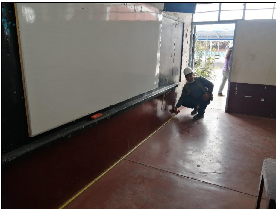
12. Comprobación de medidas en dirección transversal en los muros de albañilería.
