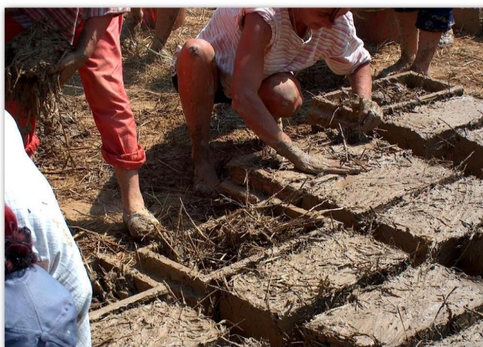
Ilustración 7 Fabricación de adobes. Fuente: (ECYT-AR, 2014)
