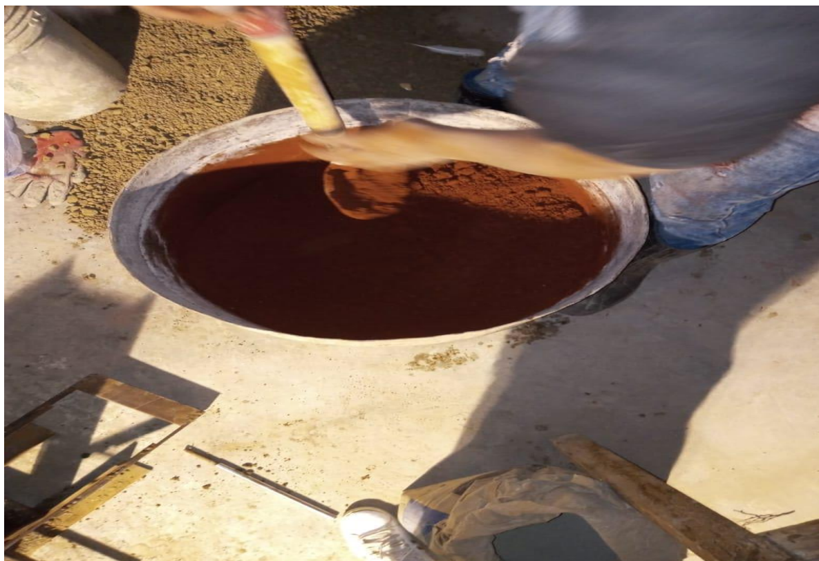
preparación de la mezcla
