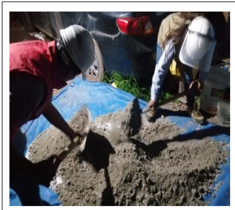
Figura 5. Imagen de la mezcla de agregados + perlas de poliestireno expandido.
