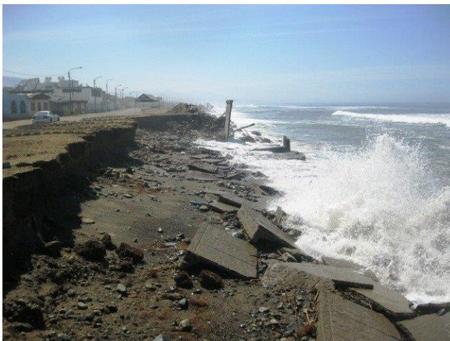
Figura 34: Muro de defensas ribereñas destruido por oleajes.
