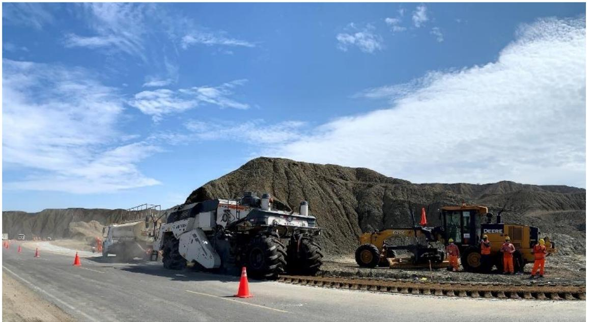
*Figura 2: Recicladora al vacío con agua.*
