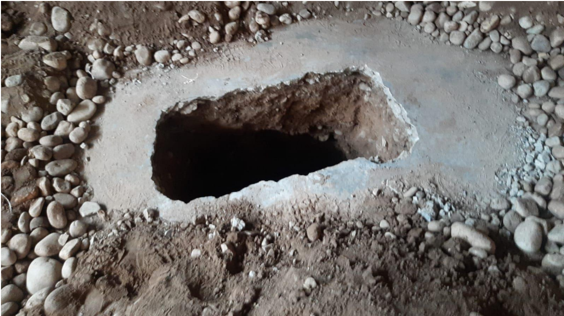
Apertura de calicatas para el estudio de suelos.
