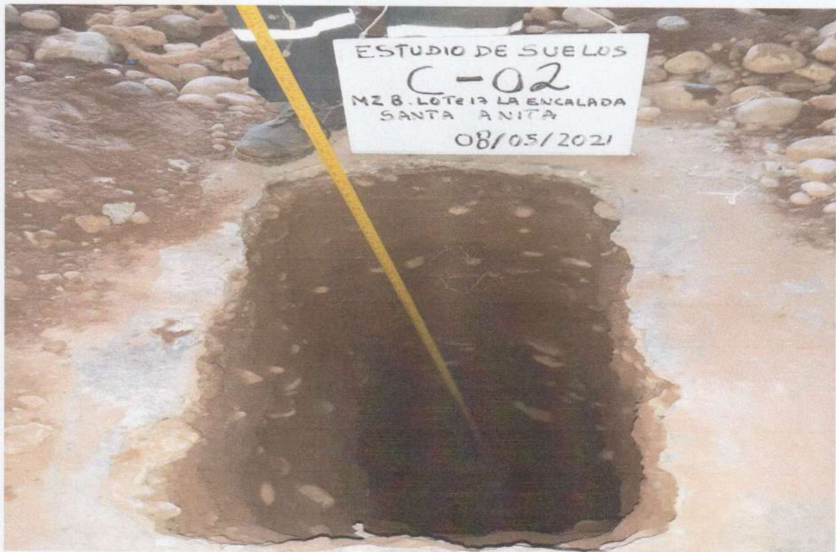
FOTO N° 06: Vista interior de la calicata C-2 donde se muestra el perfil estratigráfico del suelo que alcanza una profundidad de exploración de 3.50m. Se observa el material heterogéneo conformado por gravas y cantos sub redondeados unidos por una matriz de arena.
