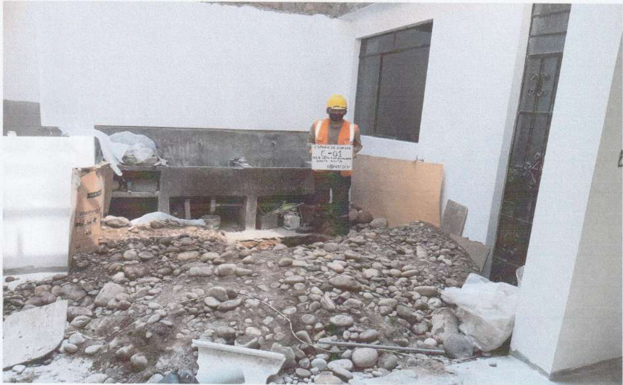
FOTO N° 03: Vista panorámica del exterior de la calicata C-1, que se ubicó en la zona de la lavandería. Se puede observar el material que de la clasificación de suelos dio como resultado una grava pobremente gradada con arena (GP).
