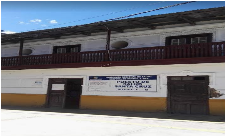
Figura 43: Centro de salud en Santa Cruz de Andamarca
