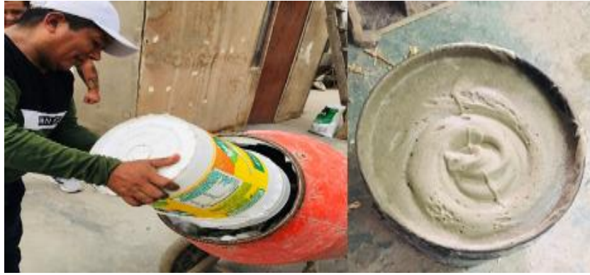
Figura 30. Añadir la espuma de acuerdo a la densidad requerida hasta obtener una mezcla homogénea.
